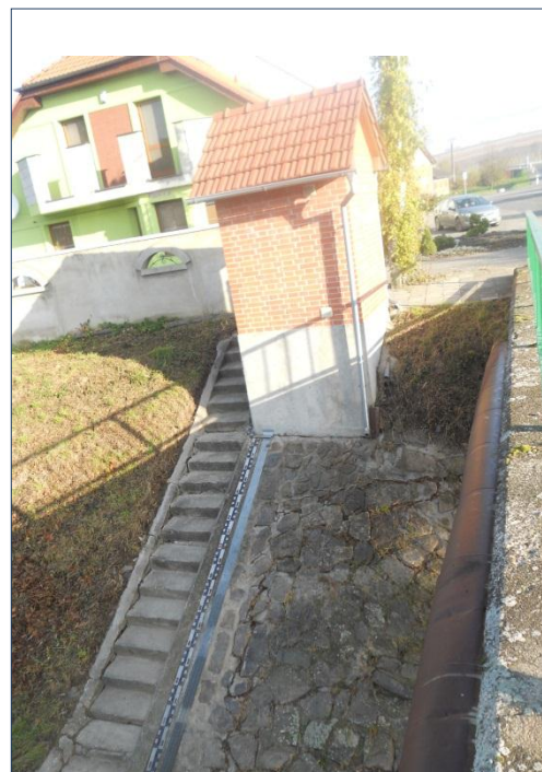
Obr. 8 Vodoměrná stanice Prusy (Radka Možišová, říjen 2013)
