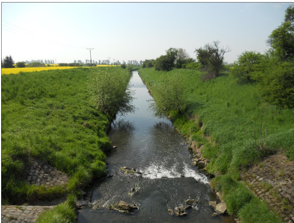
Obr. 27 Upravené koryto v obci Říkovice (foto: R. Možišová, duben 2014)
