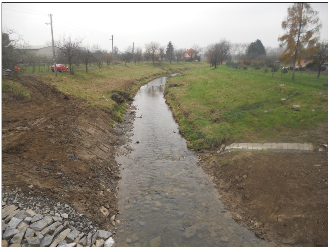
Obr. 22 Upravené koryto Moštěnky v obci Čechy (foto: R. Možišová, listopad 2013)
