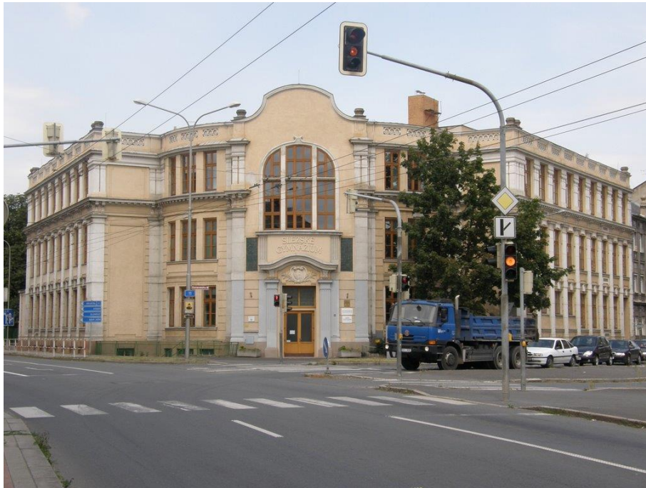
Obrázek č. 4: budova Slezského gymnázia, zdroj: http://mapio.net/s/61031324/
