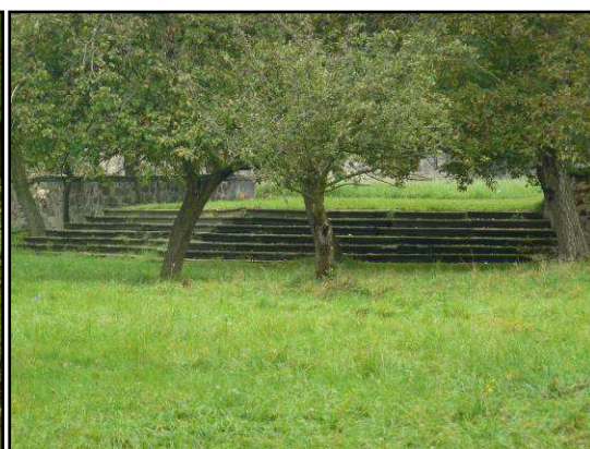
Obrázek 29 - Schodiště spojující oba parterry, foto: Dvořák, 2014
