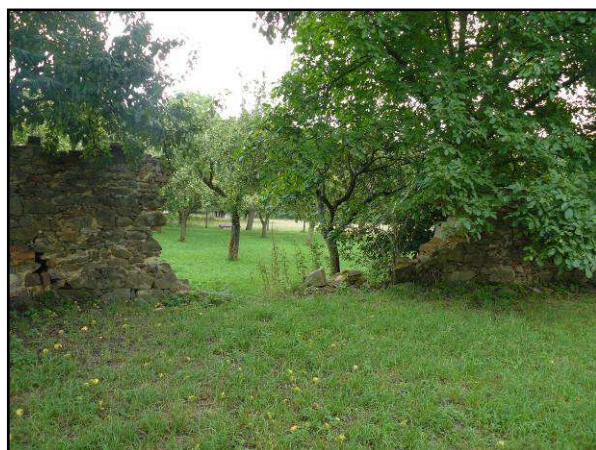
Obrázek 40 - Detail rozpadlé obvodové zdi, foto: Dvořák, 2014
