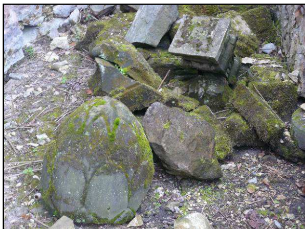
Obrázek 38 - Detail části rozbořeného schodiště západního pavilonku, foto: Dvořák, 2014
