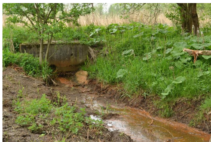
Obrázek 52 Odpadní vody přiváděné z ČOV v Bílé Vodě podzemním kanálem do odpadní strouhy (pořízeno 17.8.2014).
