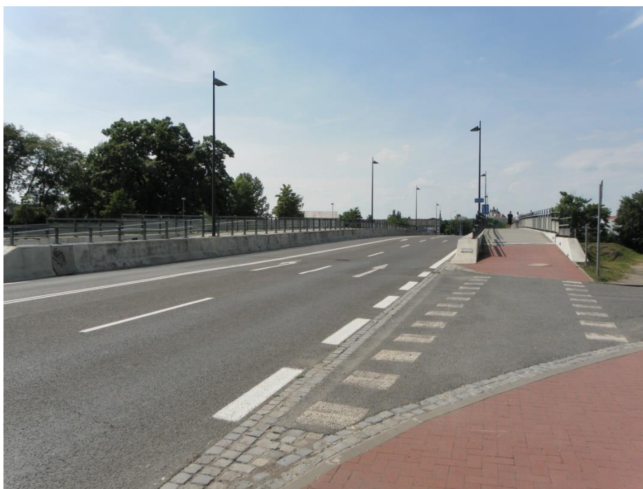
Obr. 18: Nově vybudovaný dvoupólový most přes řeku Moravu. Zdroj: (vlastní)
