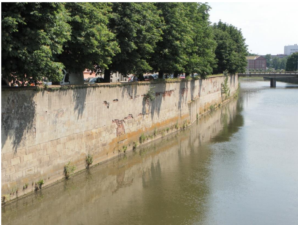
Obr. 27: Stávající zdi na ulici Blahoslavova u mostu Komenského. Zdroj: (vlastní)
