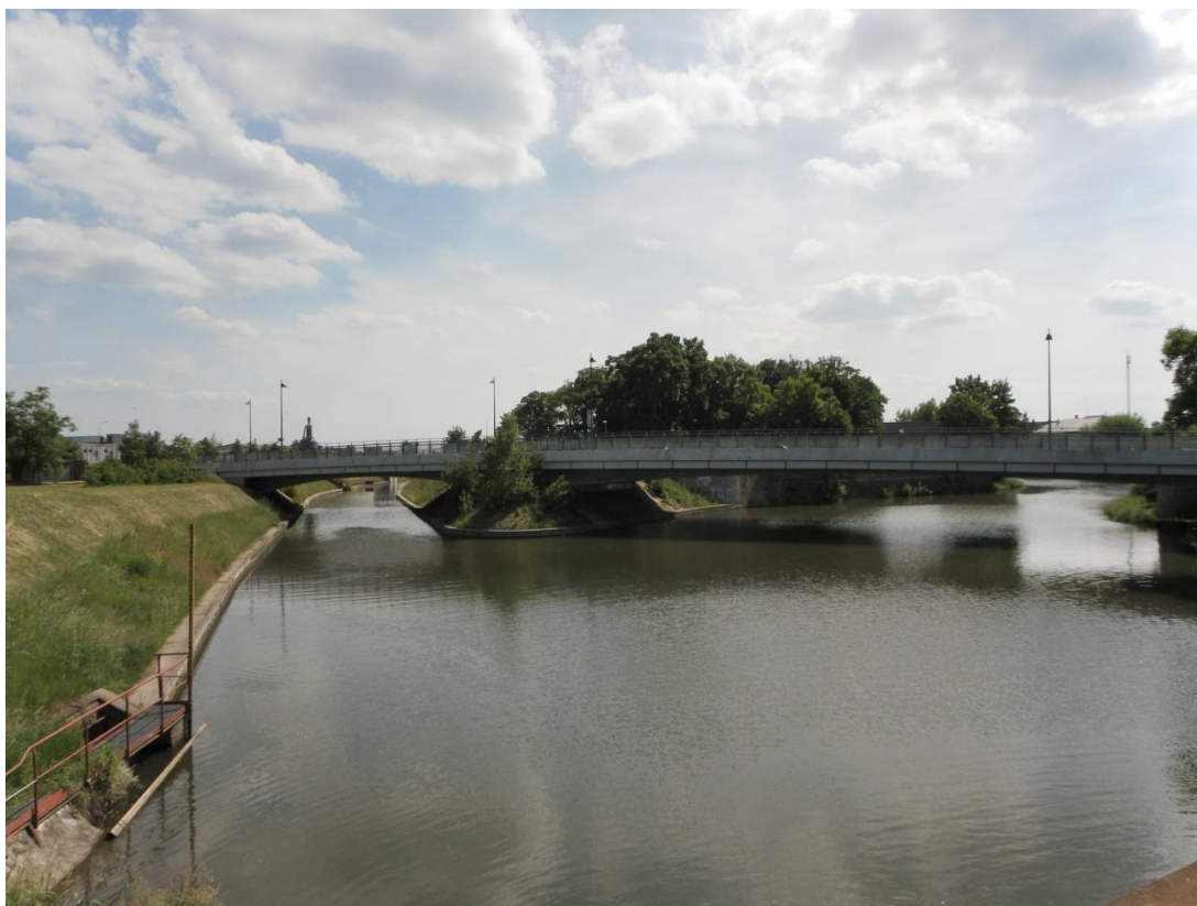
Obr. 19: Obtokový kanál na ulici Wittgensteinova, pohled na dvoupólový most. Zdroj: (vlastní)
