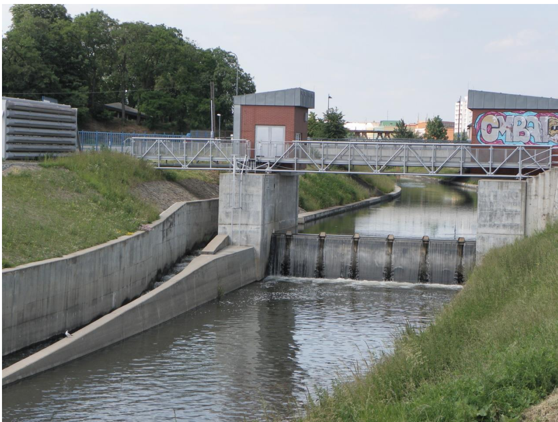
Obr. 17: Jezový objekt u plynárny s rybím přechodem. Zdroj: (vlastní)
