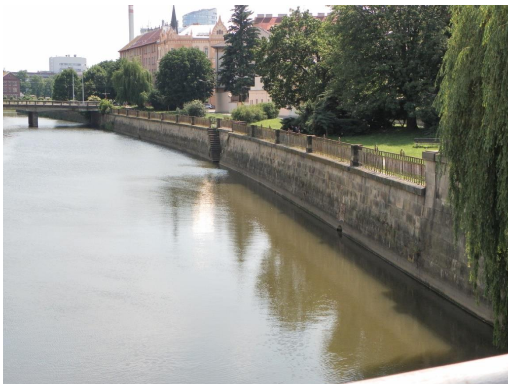
Obr. 26: Stávající zdi na ulici Blahoslavova u mostu Komenského. Zdroj: (vlastní)
