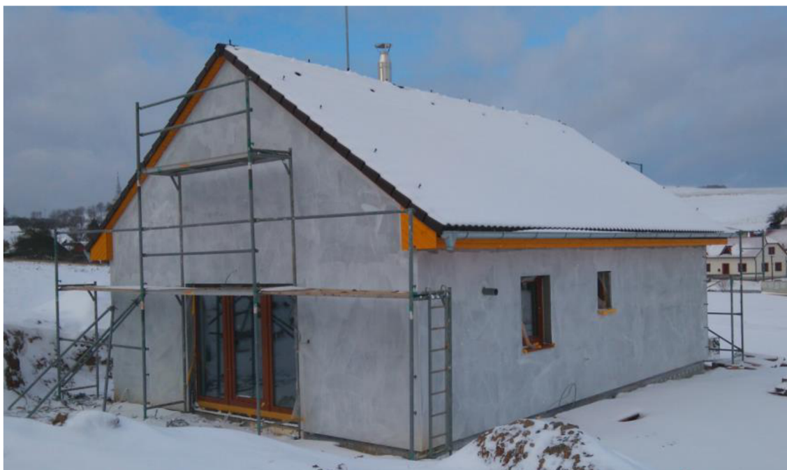
Obr. 7 Dřevostavba rodinného domu v Prosetíně [autor]
