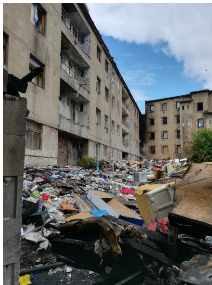
Obrázek č. 13 Nelegální skládka odpadu ve vnitrobloku ve Sklářské ulici, 19. 6. 2018 zahájení úklidu
