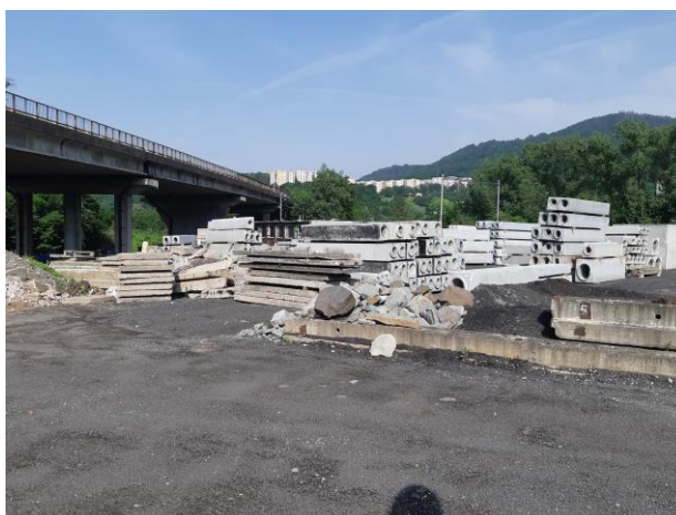
Obrázek č. 10 nelegálně skládka stavebního odpadu červen 2019
