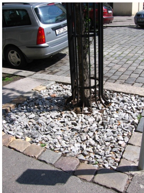
Obr. č. 15: Úprava povrchu výsadbové jámy
