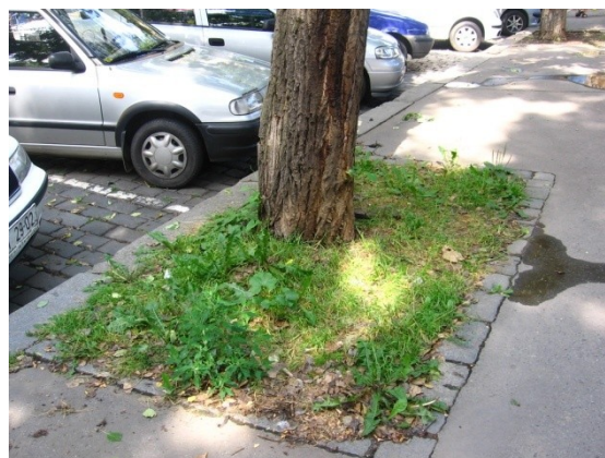
Obr. č. 31: Povrch výsadbové jámy je krytý travním porostem
