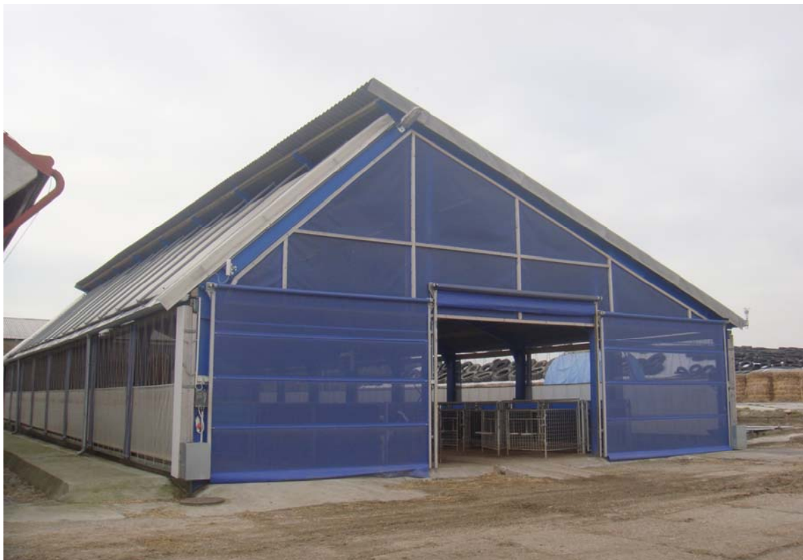
Moderní teletník ocelové konstrukce s protipřuvanovými plachtami.
