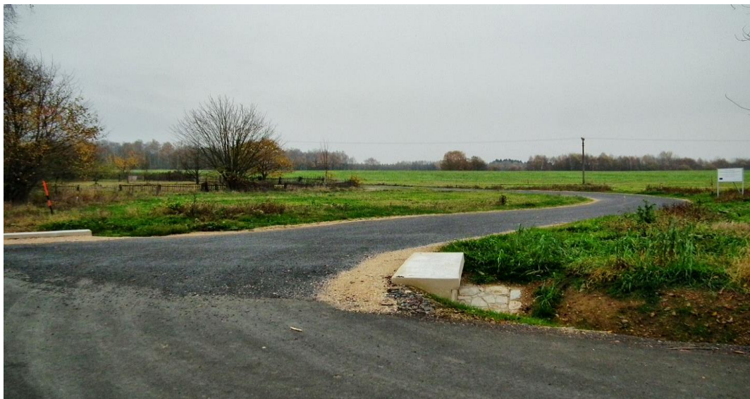
Obrázek 13: Fotografie - Napojení HPC 4 na již zrealizovanou HPC 6 (SPÚ ©2021)
