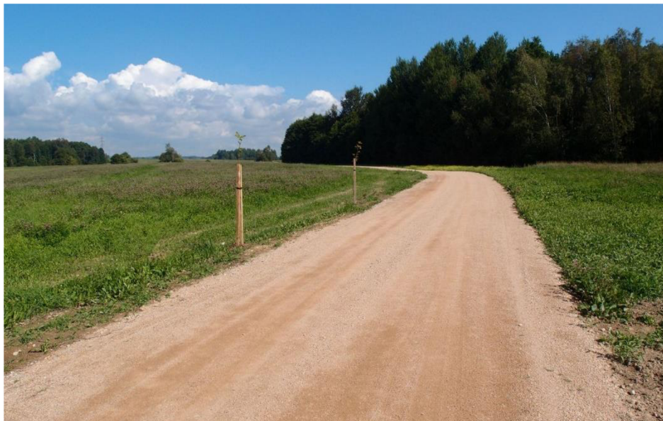
Obrázek 9: Fotografie - HPC 2 - šterkový kryt se zakalením lomovou výsivkou (SPÚ ©2021)
