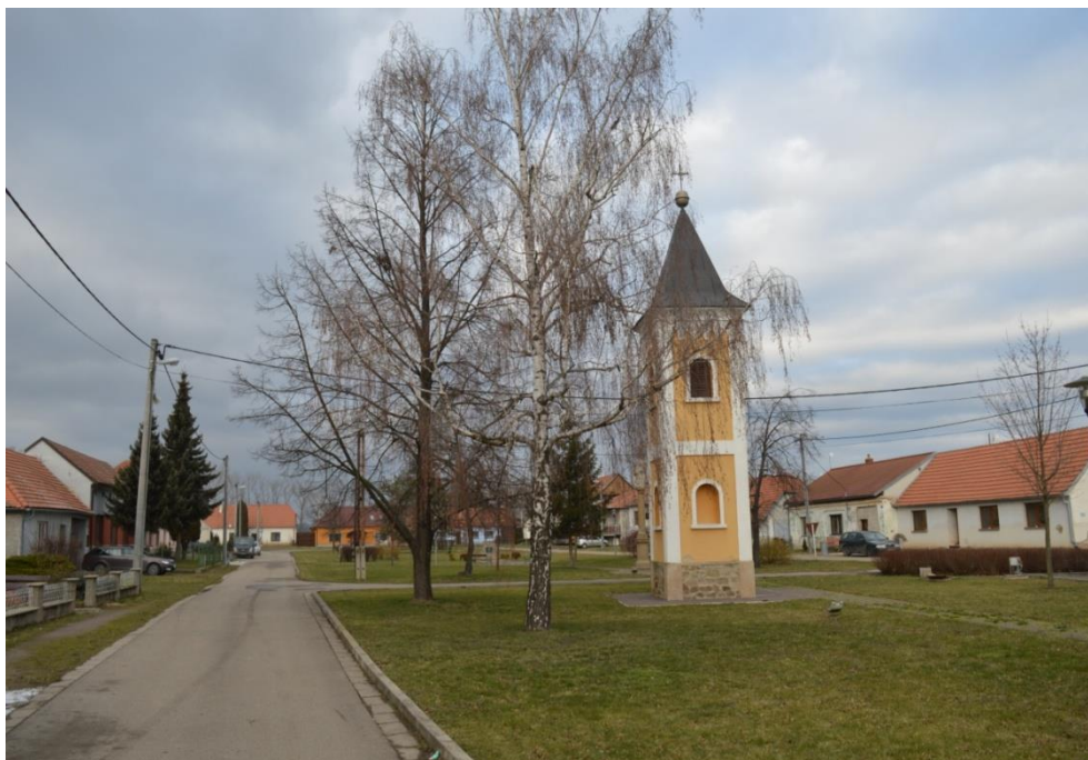
Obr. č. 18: Obytná zástavba v obci Stošíkovice na Louce.
