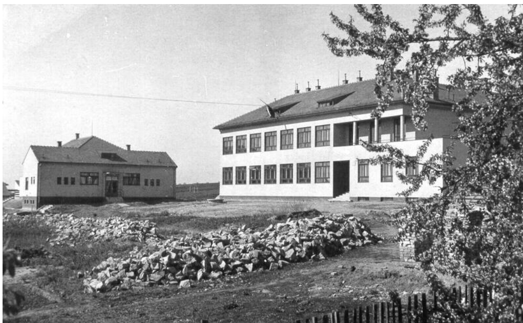
Obrázek 71: Josef Polášek, Jaroslav Bureš, Kyjov-Boršov, Mateřská a obecná škola, 1946 - 1949 Původní stav před přestavbou, Zdroj: http://www.mszskyjov.cz/ , vyhledáno 11.12.2019.
