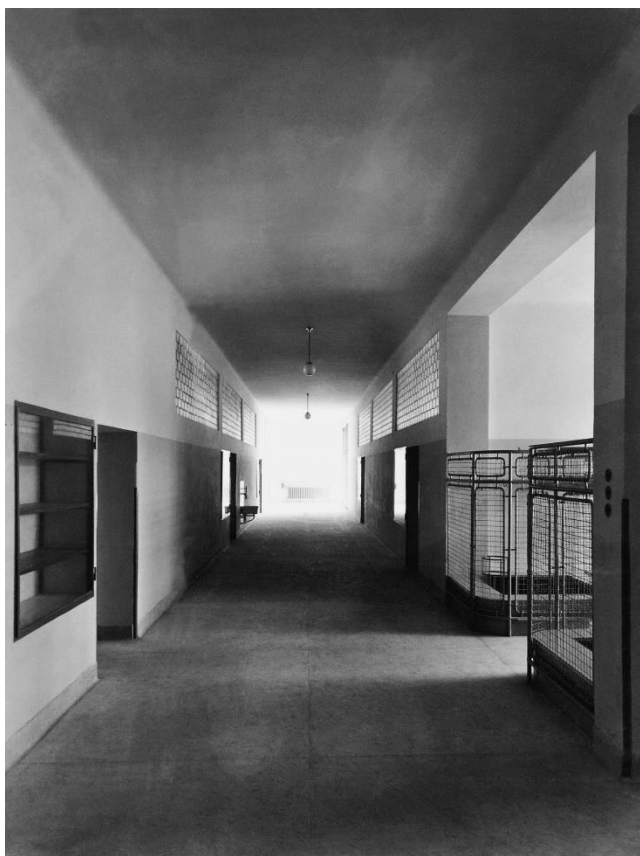
Obrázek 26: Josef Polášek, Brno, Domov přístavba Měšťanské školy Kotlářská ulice, 1930–1931, interiér prvního patra s klecovými šatnami na chodbě, Foto: https://www.bam.brno.cz/objekt/c271-pristavba-skoly , vyhledáno 11.12.2019.
