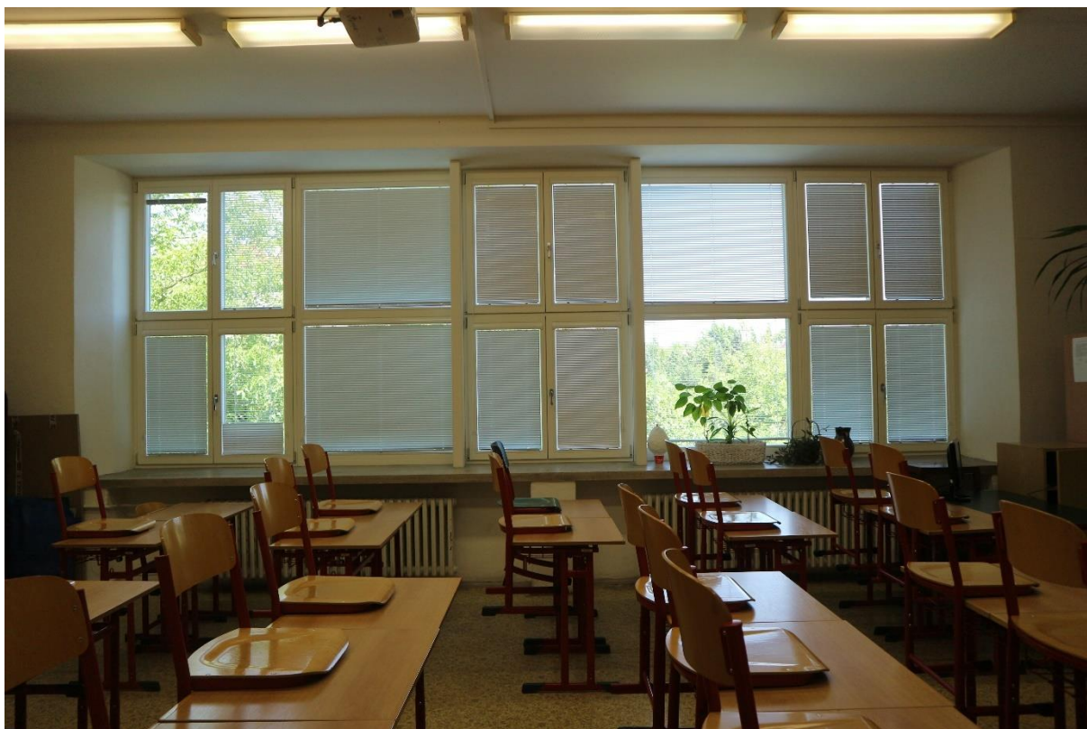
Obrázek 26: Mojmír Kyselka a Josef Polášek, Chlapecká a dívčí obecná škola, 1933 – 1934, interiér učebny s novými replikami původních oken, podpíranými sloupkem kvůli statické, Foto: Eva Vágnerová 2019.
