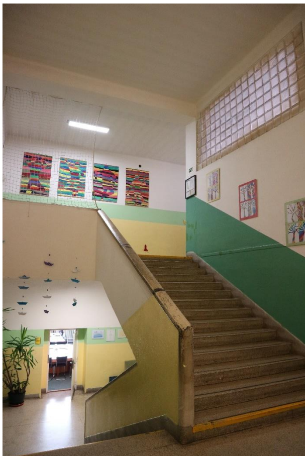
Obrázek 28: Josef Polášek, Brno, Domov přístavba Měšťanské školy Kotlářská ulice, schodiště vedoucí z prvního do druhého patra s luxferovým polem osvětlujícím ineteriér, Foto: Eva Vágnerová 2019.
