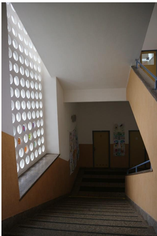
Obrázek 48: Josef Polášek, Brno, Obecná a měšťanská škola Křídlovická, 1936–1938, schodiště s polem kulatých luxferů, Foto: Eva Vágnerová 2019.
