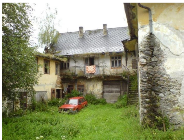
Obr. 44. Dvůr postrádá údržbu [139].
