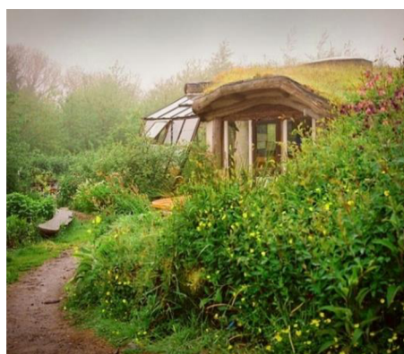
Obrázek 7: Přírodní stavitelství typické pro ekovesnici Lammas. Budova „Undercraft“ byla pro zajištění izolace instalována do svahu, z jedné strany je kryta svahem, druhá strana je otevřená na prosluněný jih. Budova byla vystavěna z místních přírodních materiálů. Jižní stranu budovy obklopuje rekultivovaný skleník, který kromě uchovávání sluneční energie nabízí využití přebytečné dešťové vody ze zelené střechy budovy (Dale S, 2016).
