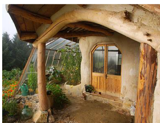
Obrázek 7: Přírodní stavitelství typické pro ekovesnici Lammas. Budova „Undercraft“ byla pro zajištění izolace instalována do svahu, z jedné strany je kryta svahem, druhá strana je otevřená na prosluněný jih. Budova byla vystavěna z místních přírodních materiálů. Jižní stranu budovy obklopuje rekultivovaný skleník, který kromě uchovávání sluneční energie nabízí využití přebytečné dešťové vody ze zelené střechy budovy (Dale S, 2016).
