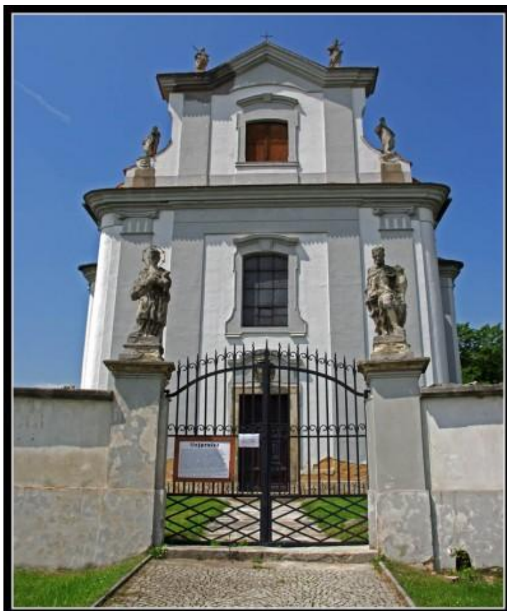
Obr. 42 – F. M. Kaňka fasáda kostela ve Vejprnicích
