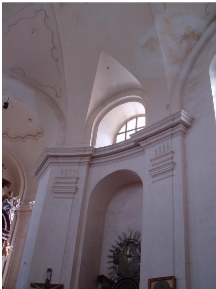
Obr. 11 – detail kordonové římsy
