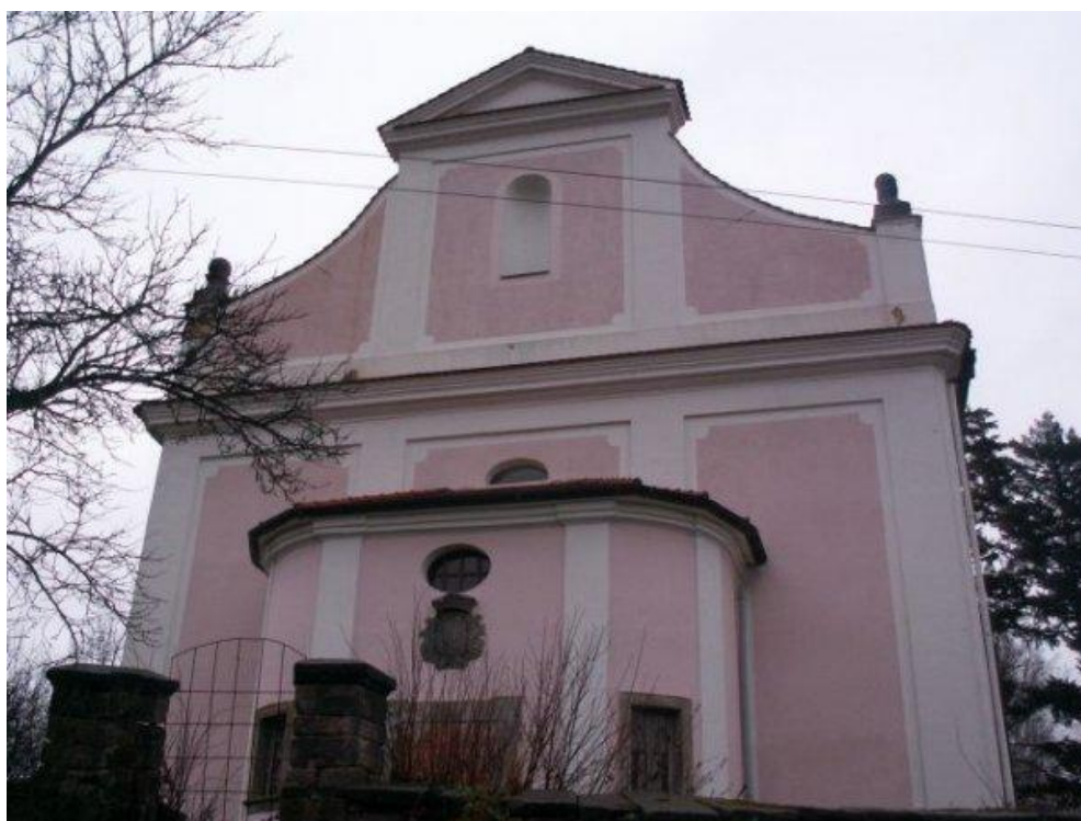
Obr. 22 – detail západního průčelí
