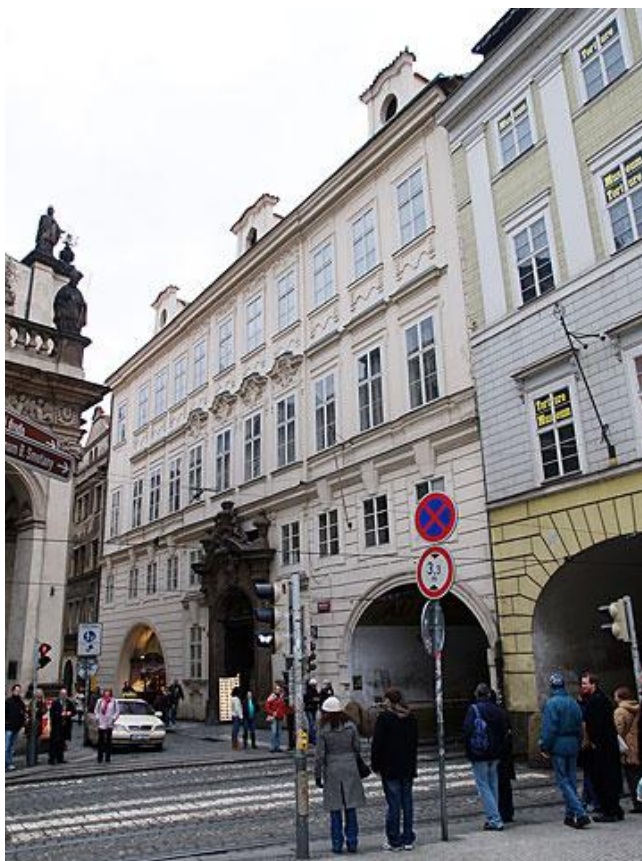
Obr. 23 – hlavní průčelí paláce Colloredo Mansfeld
