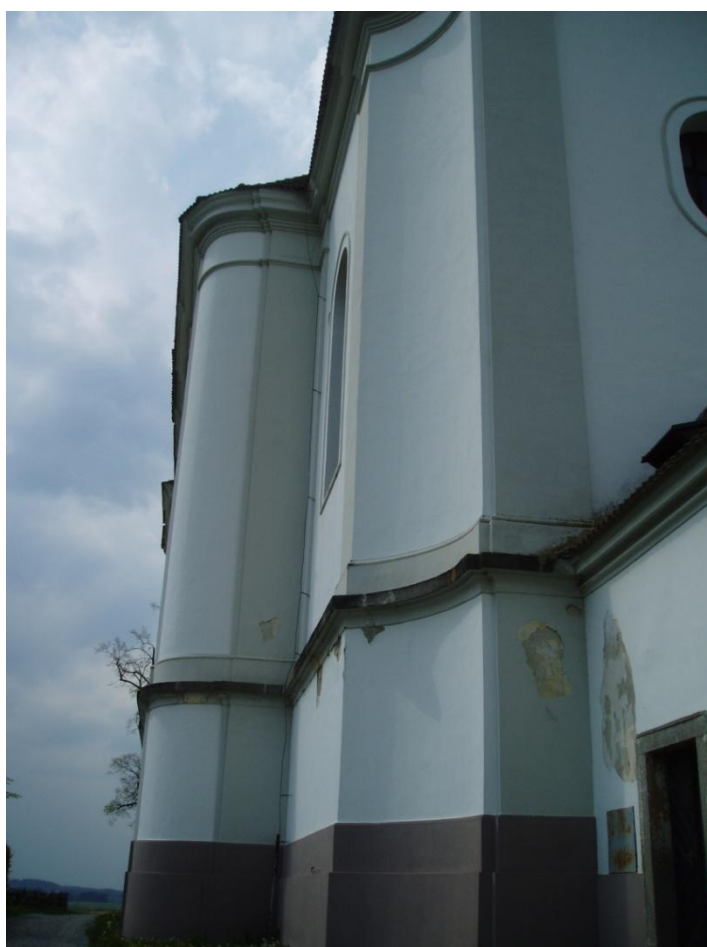
Obr. 6 – detail vyžlabení východní stěny
