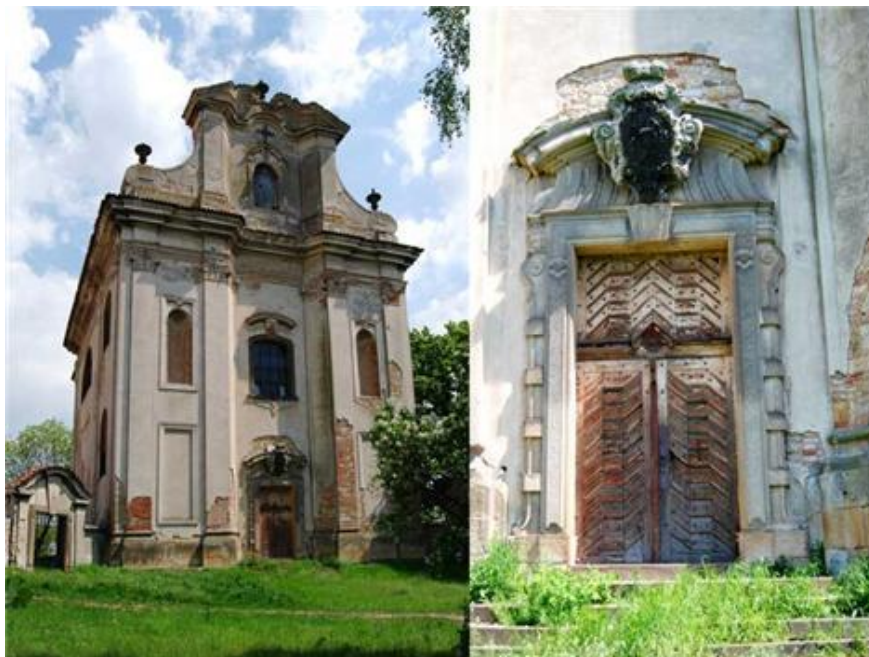
Obr. 47 – detail fasády a hlavního portálu
