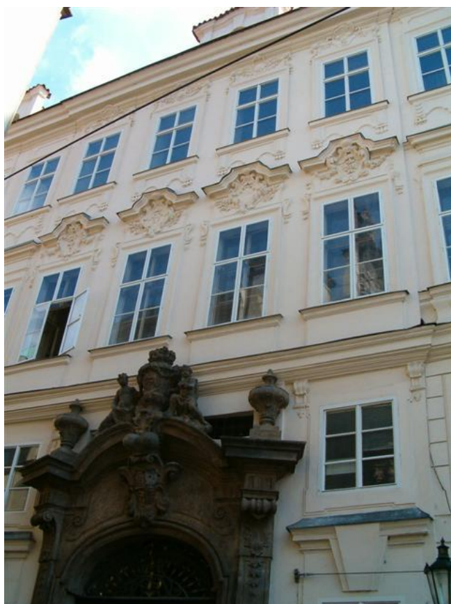
Obr. 24 – detail hlavního průčelí
