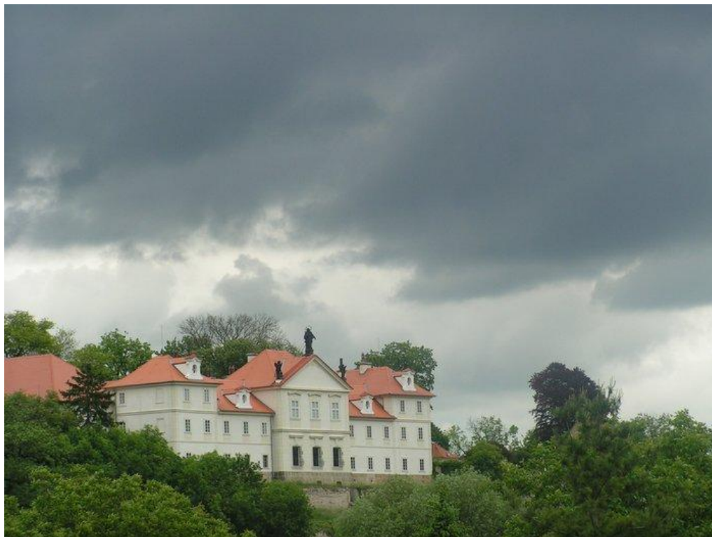
Obr. 28 – klášter bosých augustiniánů, jižní stěna
