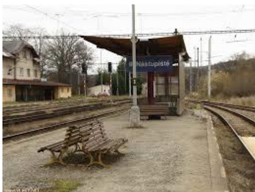
Železniční stanice v Kostelci
