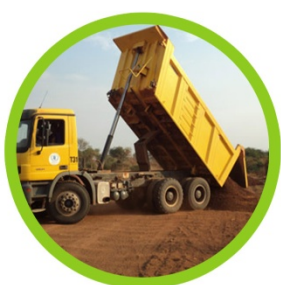
4. Odvoz kontaminované půdy na biodegradační plochu
