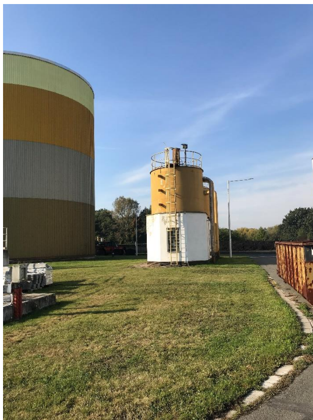
Příloha 11 Homogenizační nádrže
