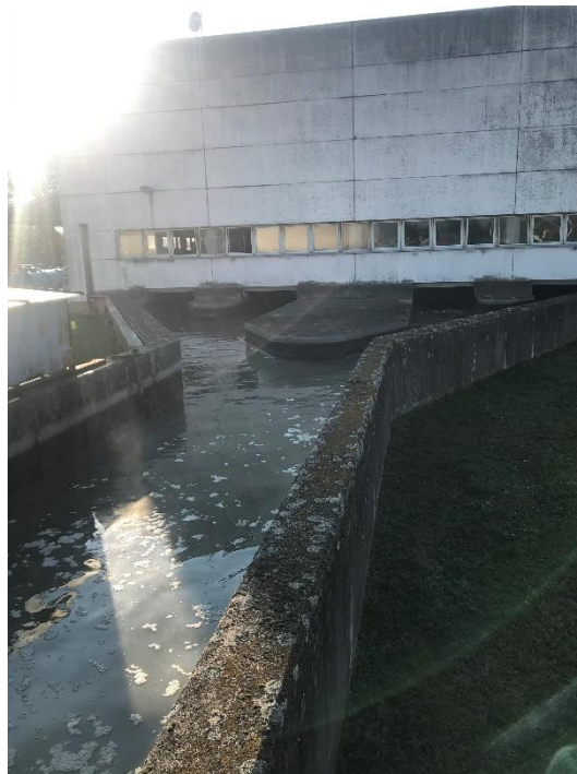
Příloha 3 Přítok vody do česlovny
