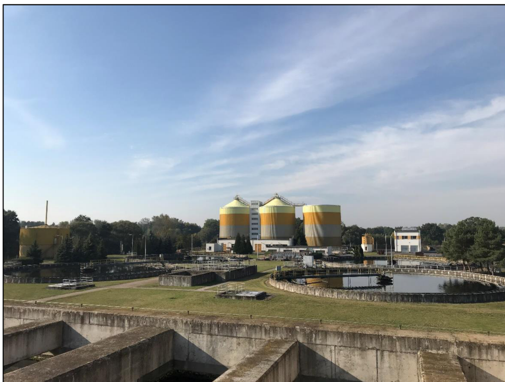
Obrázek 13 Pohled na dosazovací nádrže s vyhřívacími nádržemi na anaerobní zpracování kalu v pozadí
