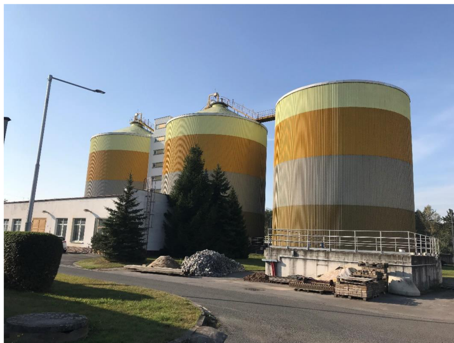
Příloha 10 Vyhňivací nádrže pro anaerobní fermentaci kalu
