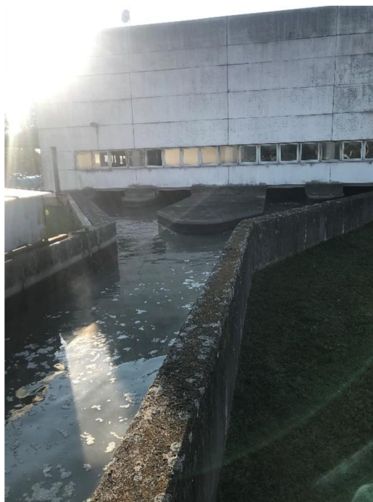
Příloha 3 Přítok vody do česlovny
