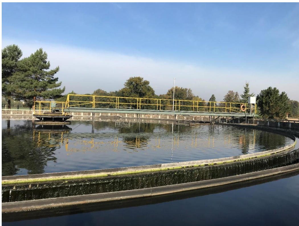
Příloha 9 Dosazovací nádrž
