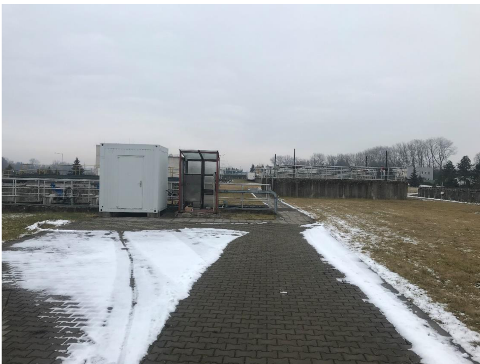
Příloha 15 Místo, kde by byla umístěna recyklační jednotka
