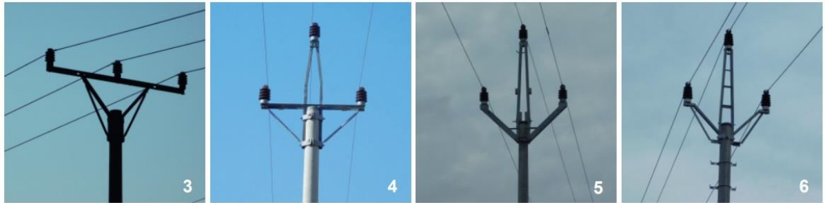
Obrázek 18 Čtyři základní typy konzol užívaných na elektrických linkách vysokého napětí v České republice: rovinná konzola s podpěrnými izolátory („sloup smrti“; 3), Delta (4), Pařát (5) a Delta variant (6) (Škorpíková et al. 2019).
