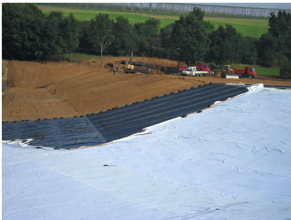
Obr. č. 32 – Výstavba 2 etapy skládky Žeravice II – Přerov (Čoček, 2014)
