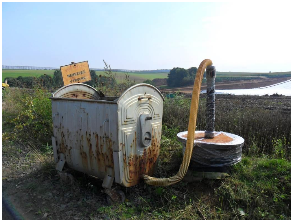
Obr. č. 11 – Kokso-kompostový filtr na skládce Žeravice II – Přerov (Čoček, 2015)
