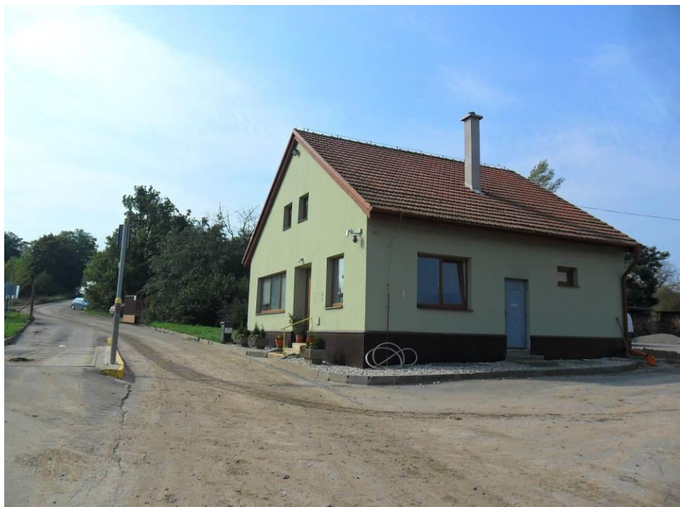
Obr. č. 25 – Vstupní budova na skládku Žeravice II – Přerov (Čoček, 2014)
