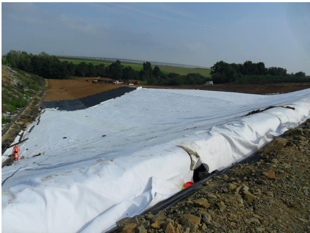
Obr. č. 9 – Výstavba 2. etapy skládky Žeravice II – Přerov (Čoček, 2014)
