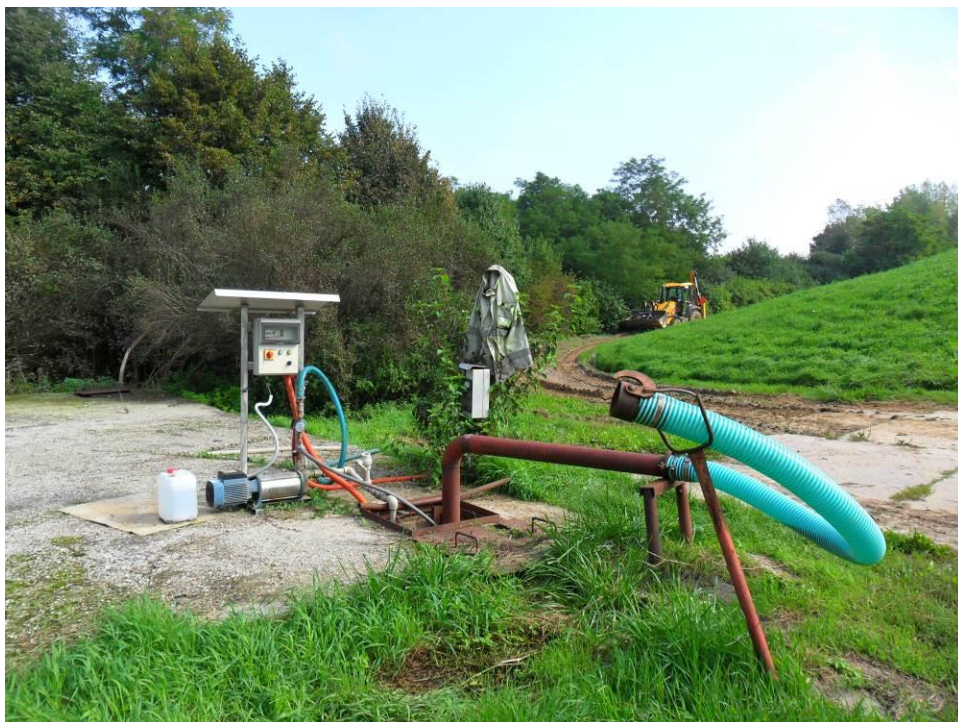
Obr. č. 29 – Železo betonová jímka (Čoček, 2014)
