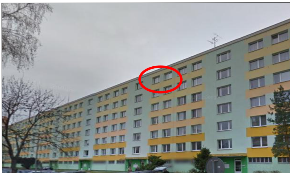
Obr. č. 30 – Byt č. 8; bytový dům
