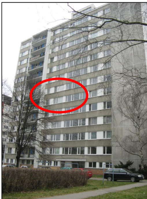
Obr. č 32 – Byt č. 9; bytový dům
