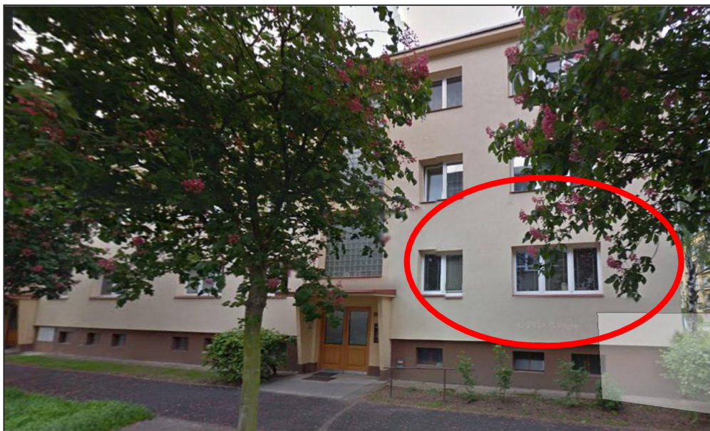
Obr. č. 26 – Byt č. 6; bytový dům
