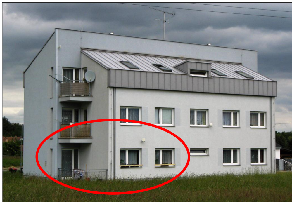
Obr. č. 16 – Byt č. 1; bytový dům
