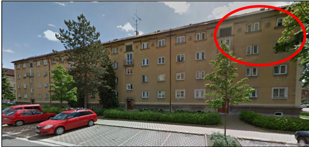
Obr. č. 24 – Byt č. 5; bytový dům
