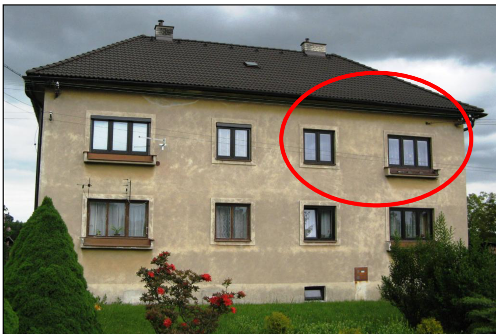
Obr. č. 20 – Byt č. 3; bytový dům
