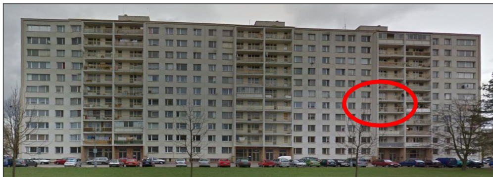
Obr. č. 28 – Byt č. 7; bytový dům
