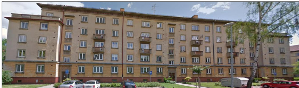
Obr. č. 22 – Byt č. 4; bytový dům
