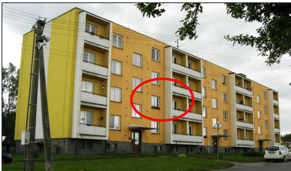
Obr. č. 18 – Byt č. 2; bytový dům
