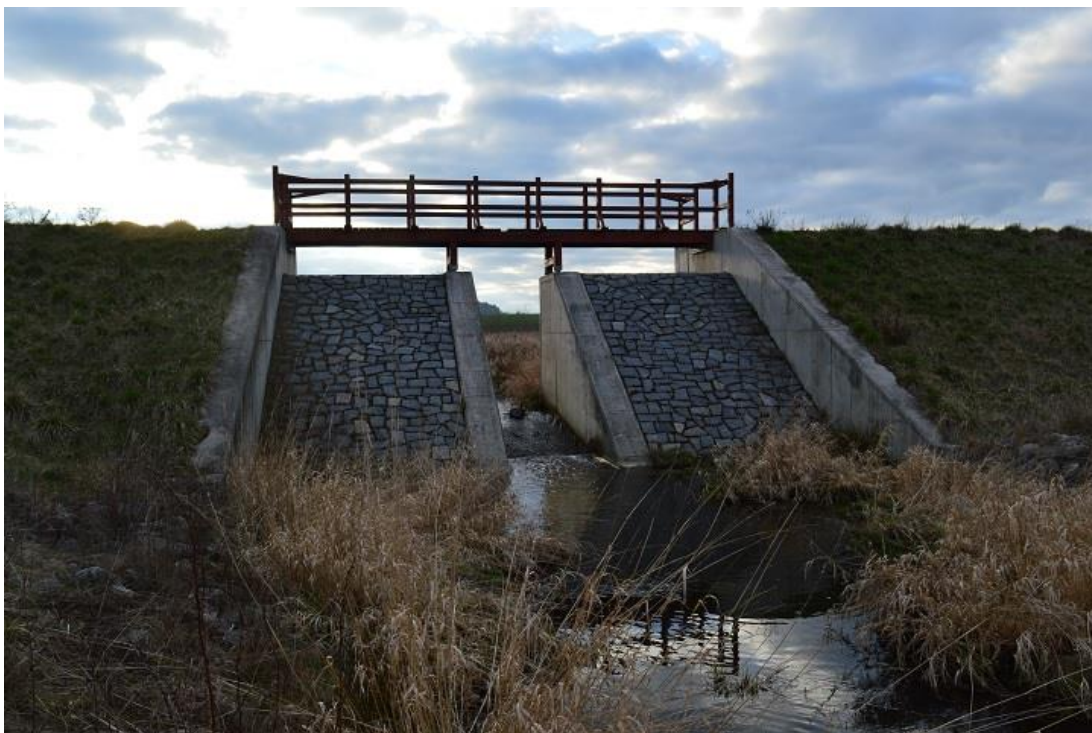
Příloha č. 16: Detail funkčního objektu suchého poldru ze vzdušné strany (zdroj: archiv autora)
