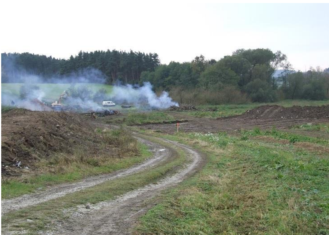
Příloha č. 4: Úprava povrchu a odstranění vegetace v zátopovém území suchého poldru (zdroj: archiv obce Cehnice)
