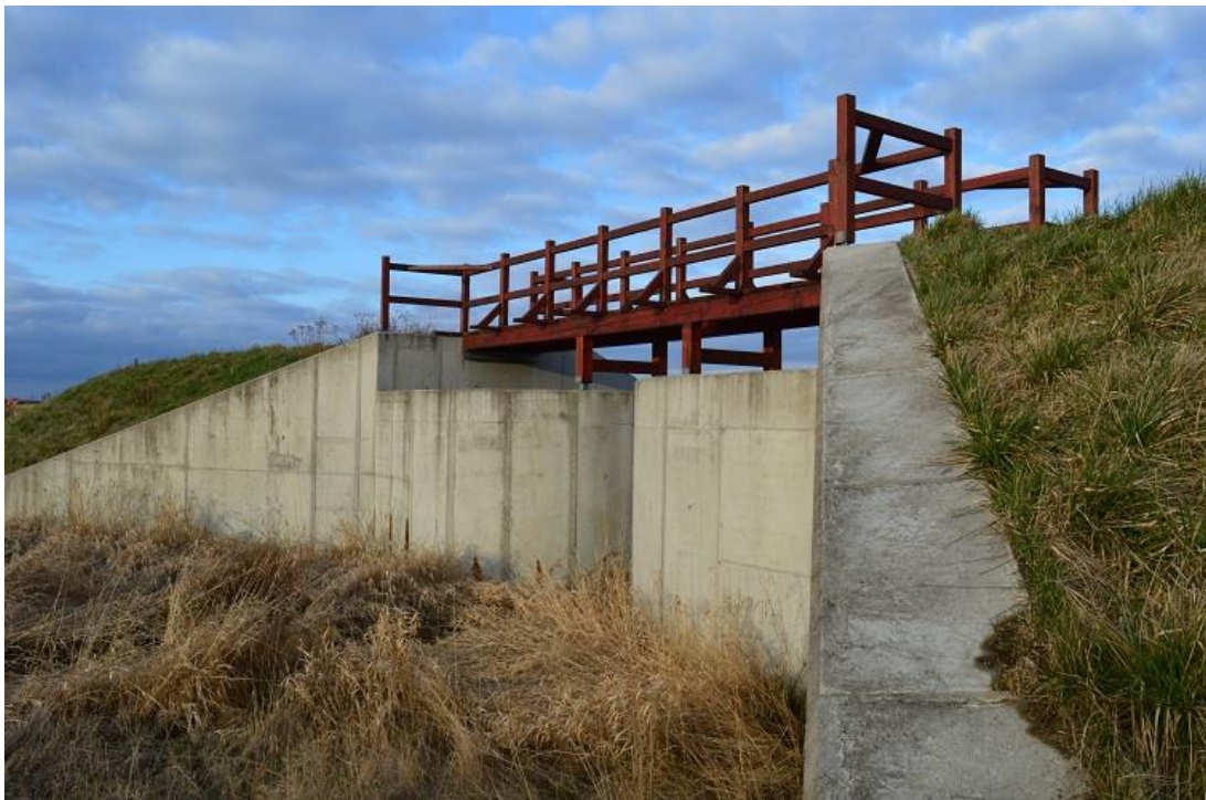
Příloha č. 15: Detail funkčního objektu suchého poldru z návodní strany (zdroj: archiv autora)
