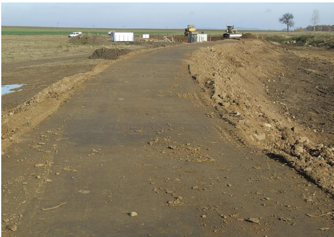
Příloha č. 8: Výstavba sypané hráze suchého poldru (zdroj: archiv obce Cehnice)
