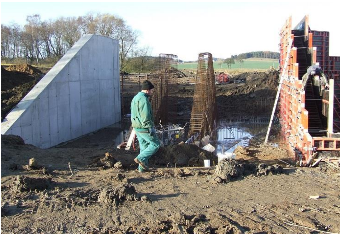
Příloha č. 6: Výstavba železobetonových zdí funkčního objektu suchého poldru (zdroj: archiv obce Cehnice)
