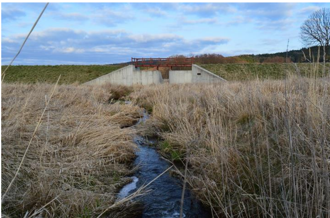
Příloha č. 14: Funkční objekt suchého poldru, kterým protéká Cehnický potok (zdroj: archiv autora)
