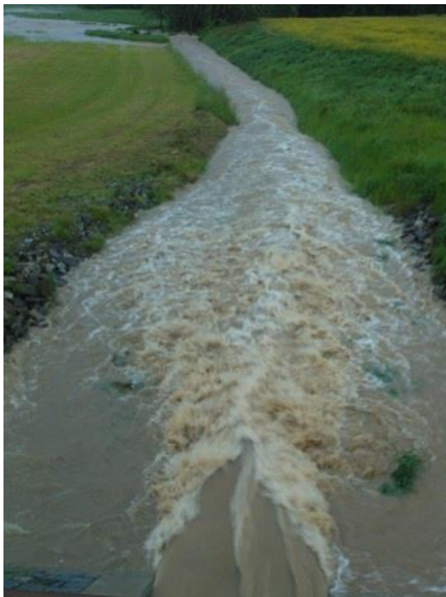
Příloha č. 20: Vývařiště suchého poldru a koryto Cehnického potoka pod hrází při povodni 2013 – mimo kulminační průtok (zdroj: archiv obce Cehnice)
