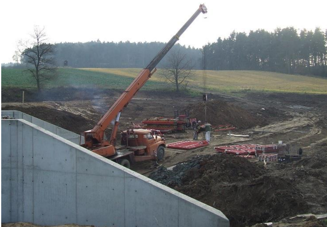
Příloha č. 7: Výstavba suchého poldru (zdroj: archiv obce Cehnice)
