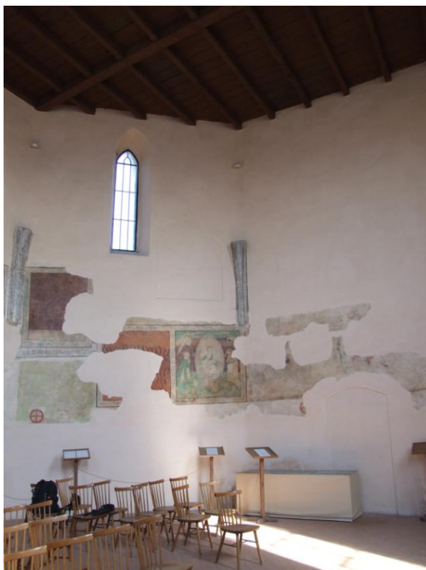
Obr. 204 Opava – Kateřinky, kaple sv. Kříže, interiér, pohled od jihu na severní a severozápadní stěnu se zarděným portálem do sakristie v přízemí a do schodišťové věžičky v patře vpravo od okna.
