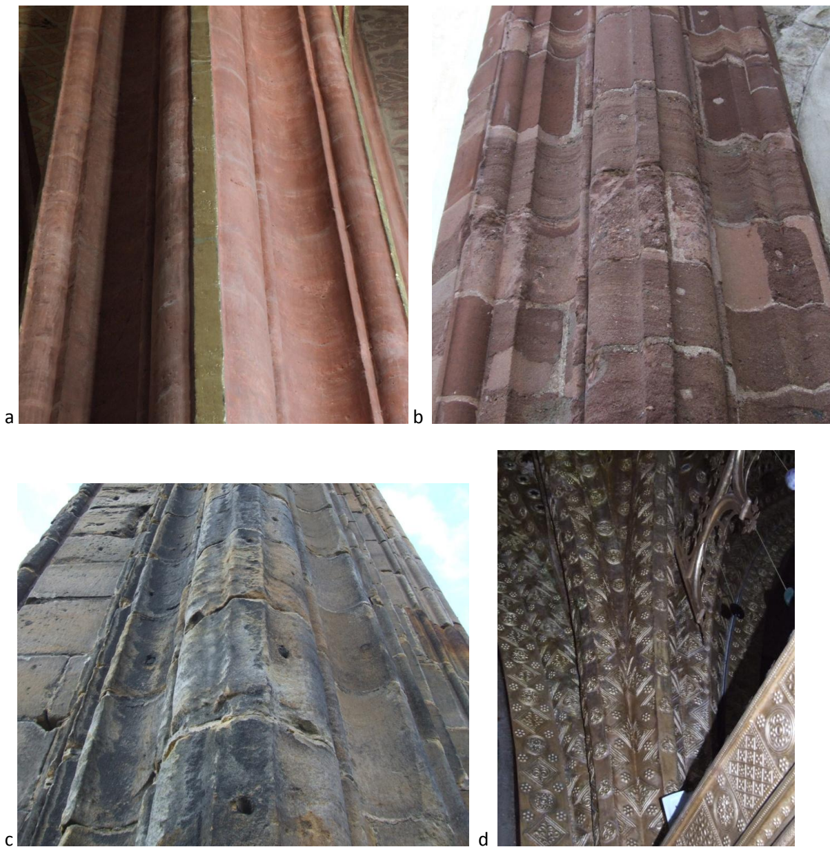
Obr. 80 a – 83 d Komparace tvarosloví profilace arrasovsky zploštělých hruškovců.
