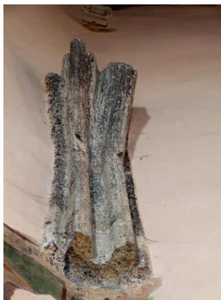
Obr. 206 a, b Opava – Kateřinky, kaple sv. Kříže, interiér, fragmenty hruškovcových kleneb. výběhů.
