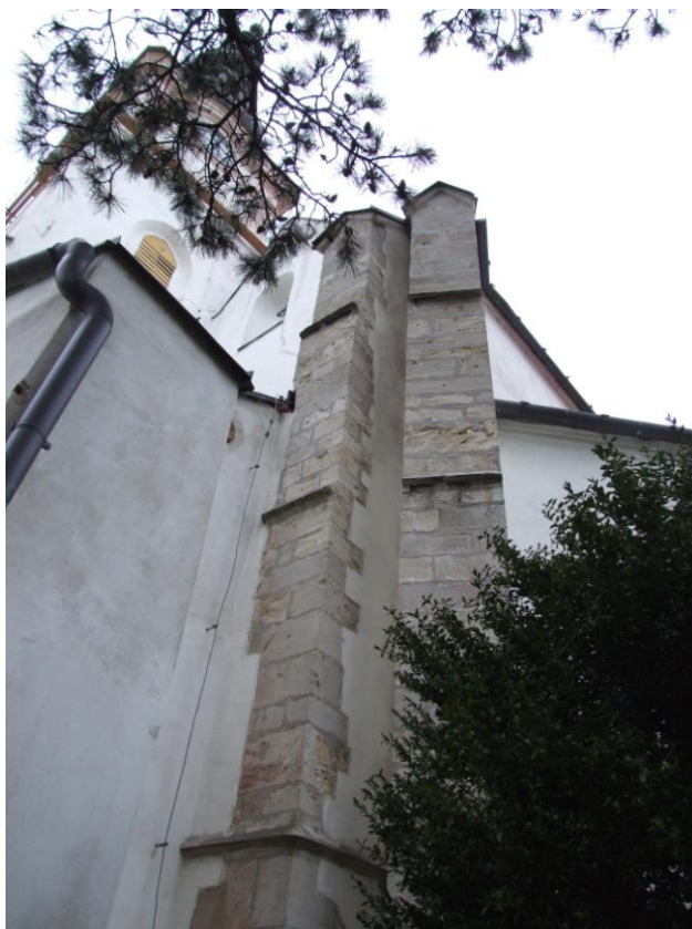
Obr. 126 Kostel Panny Marie v Novém Městě nad Váhem, zdvojení opěrného pilíře lodi na JZ nároží.
