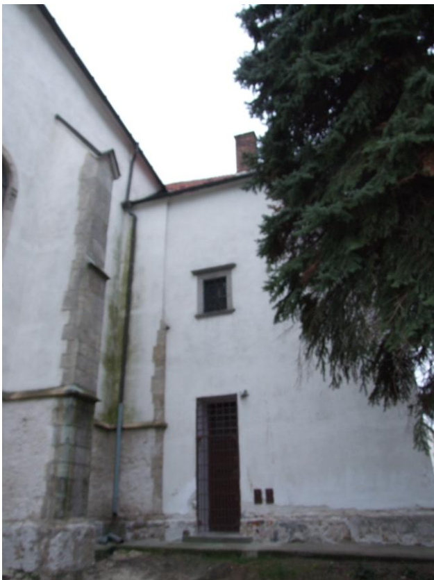
Obr. 135 Kostel Panny Marie v Novém Městě nad Váhem, východní průčelí sakristie.
