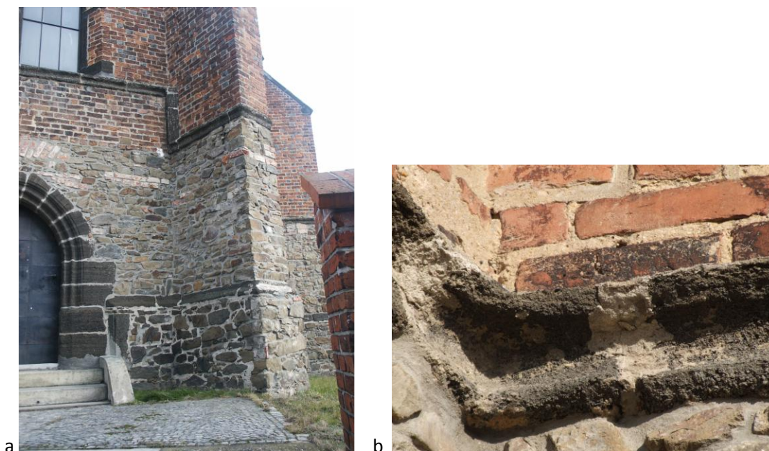
Obr. 179 a Opava – Kateřinky, kaple sv. Kříže, detail dvou úrovní lomového zdiva průčelí kaple, spodní soklová část oddělená soklovou římsou a nad ní lomové zdivo, oddělené kordonovou římsou, nad ní svrchní část zdiva cihlového.
