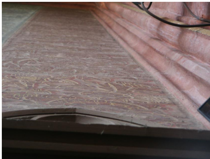
Obr. 43 a – 44 b Kostel P. Marie a sv. Karla Velikého Karlově v Praze 43 a Detail zdrsnění po původní podokenní římse presbytáře, severní stěna. 44 b Detail zdrsnění po původní podokenní římse presbytáře, jižní stěna.
