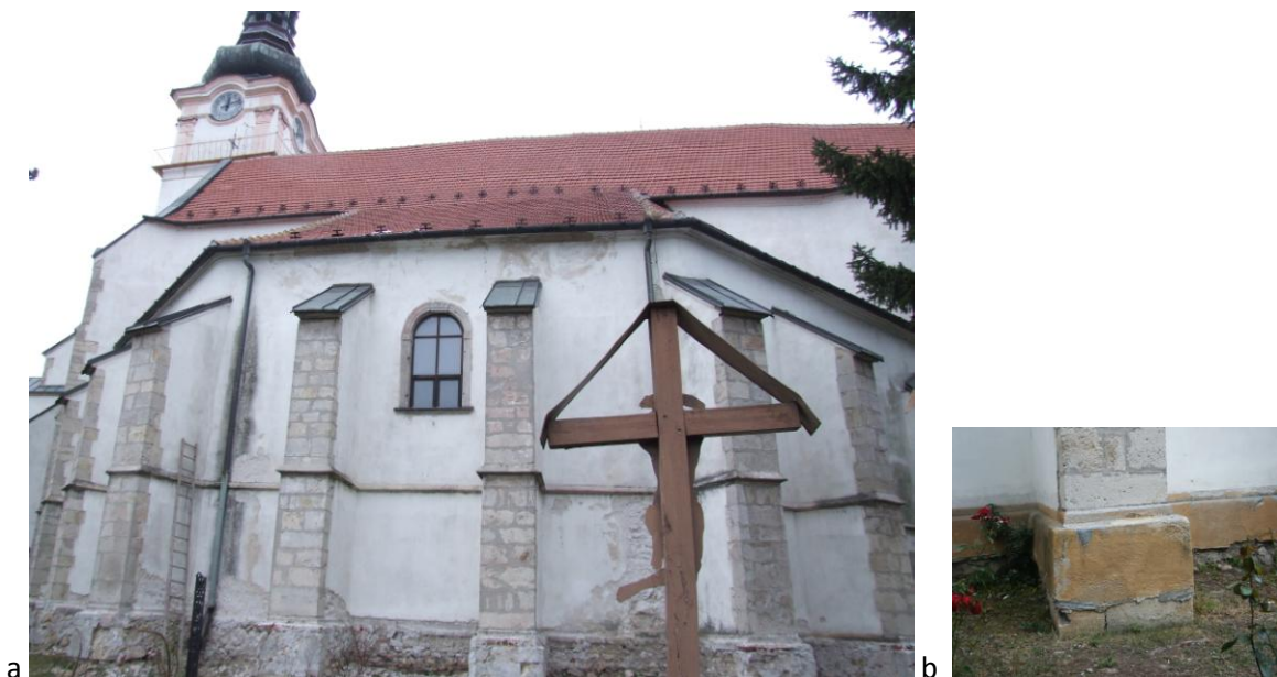
Obr. 128 a Kostel Panny Marie v Novém Městě nad Váhem, elevace lodi – pohled od jihu. Obr. 129 b Detail soklu opěrných pilířů lodi.
