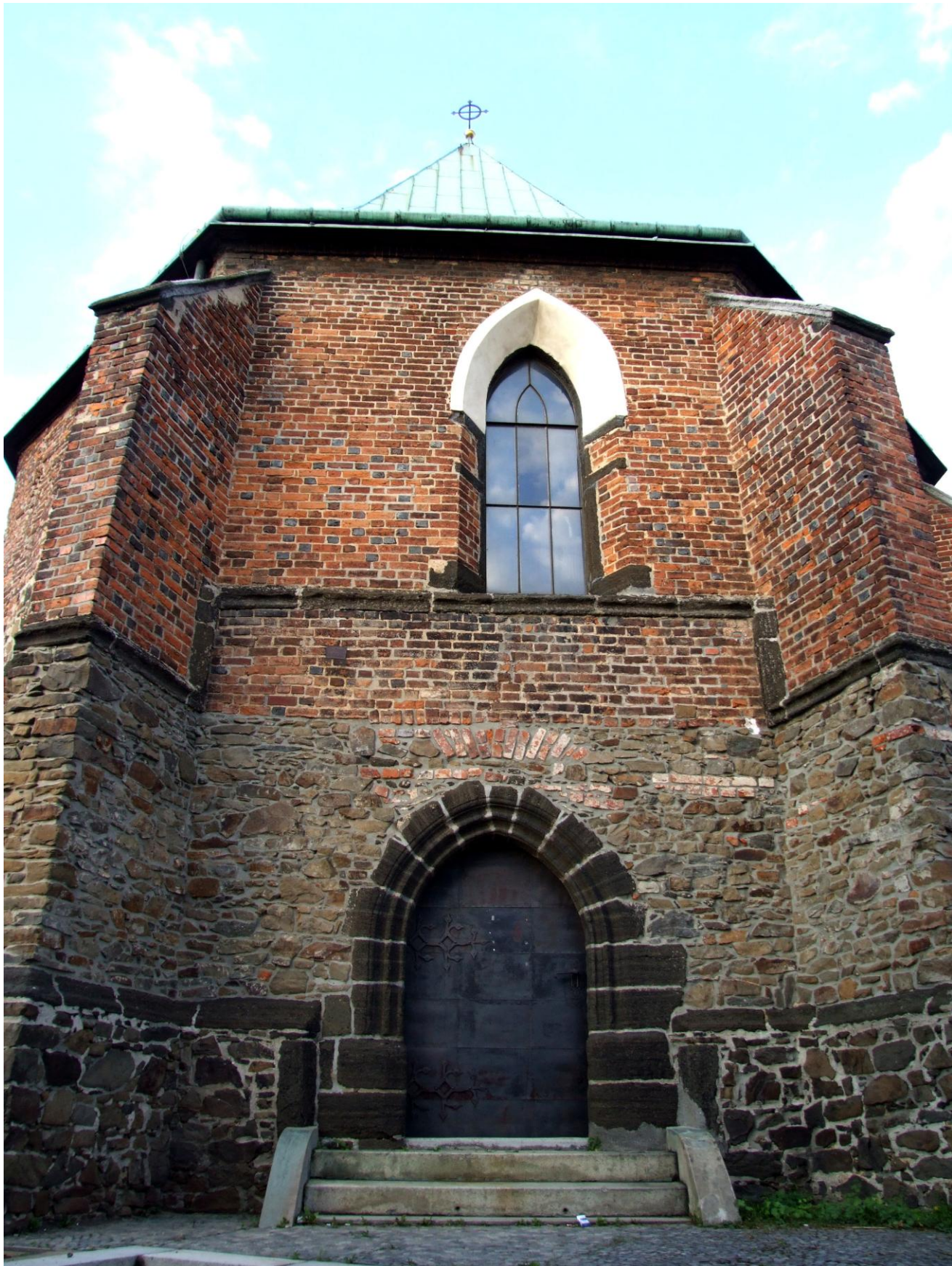
Obr. 175 Opava – Kateřinky, kaple sv. Kříže, pohled na západní průčelí s hlavním vstupním portálem.
