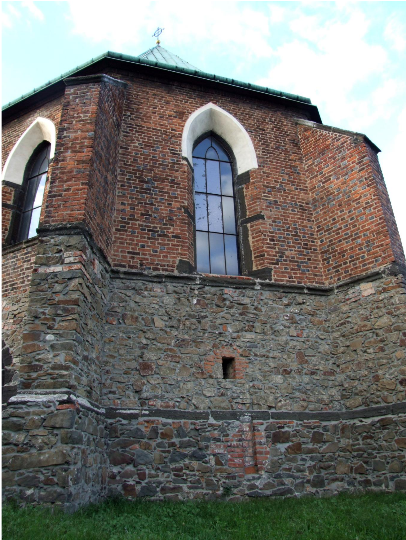
Obr. 181 Opava – Kateřinky, kaple sv. Kříže, pohled na jihozápadní průčelí.
