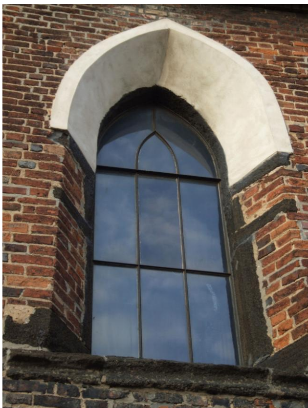
Obr. 176 Opava – Kateřinky, kaple sv. Kříže, okno západního průčelí.
