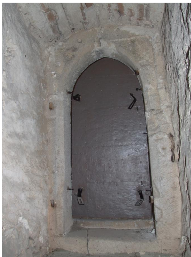
Obr. 164 Kostel Panny Marie v Novém Městě nad Váhem, lomený portál do depozitáře nad sakristií, přístupný z interiéru točitého schodiště.
