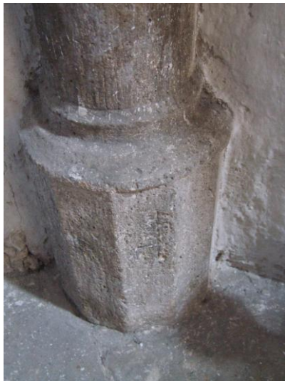
Obr. 152 a Kostel Panny Marie v Novém Městě nad Váhem, detail soklu válcové přípory presbytáře.
