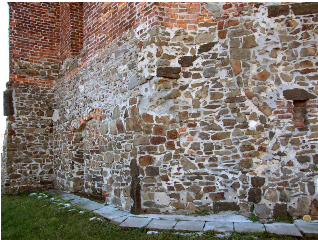
Obr. 194 Opava – Kateřinky, kaple sv. Kříže, situace při severozápadním nároží – sakristie. Schodišťová věžička, projevující se negativním vtiskem do hmoty kaple. Fragменты stupňů a portálu ze sakristie do věže.
