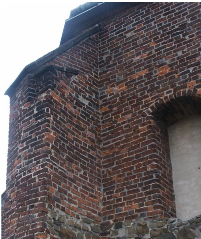
Obr. 199 Opava – Kateřinky, kaple sv. Kříže, detail vzájemného vztahu opěrných pilířů sakristie.
