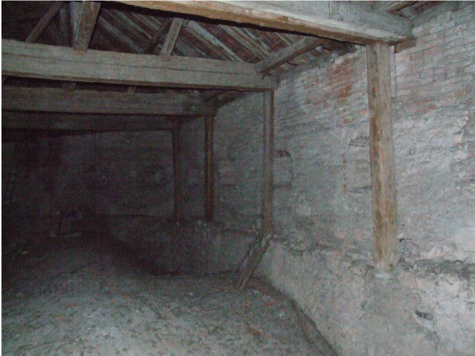
Obr. 158 Kostel Panny Marie v Novém Městě nad Váhem, sekundárně vystavěné zdivo se střílnami nad severní boční lodí.
