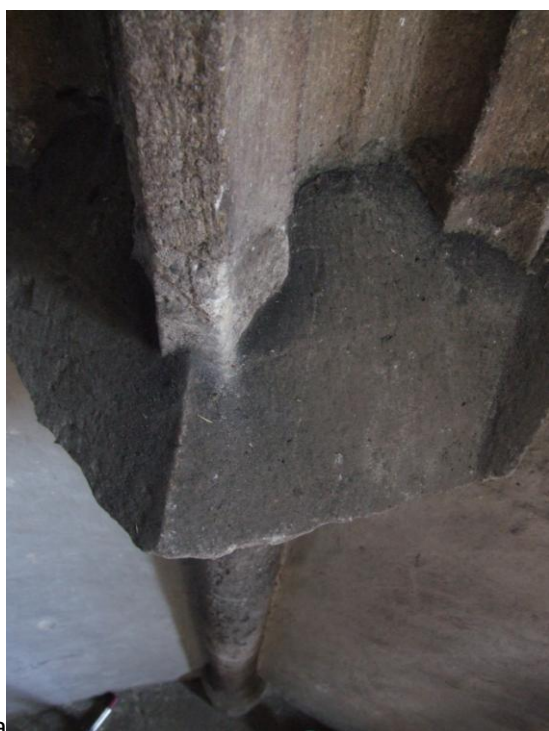
Obr. 147 a Kostel Panny Marie v Novém Městě nad Váhem, elevace válcové přípory presbytáře.
