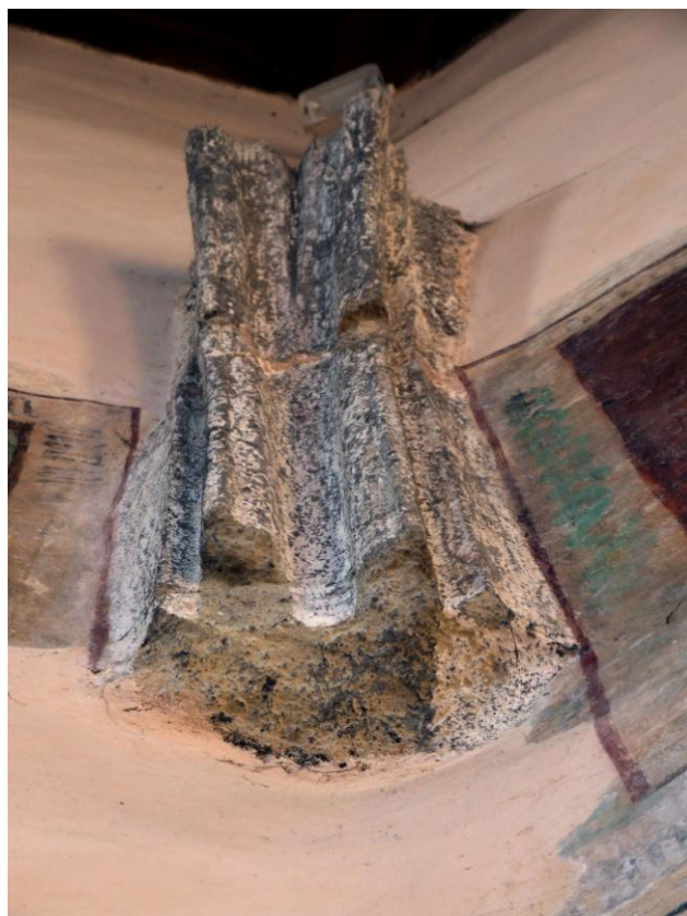
Obr. 206 a, b Opava – Kateřinky, kaple sv. Kříže, interiér, fragmenty hruškovcových kleneb. výběhů.
