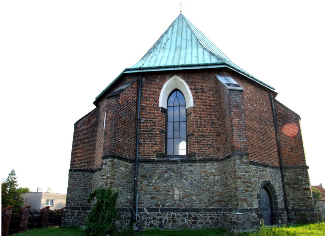
Obr. 174 Opava – Kateřinky, kaple sv. Kříže, pohled od východu.
