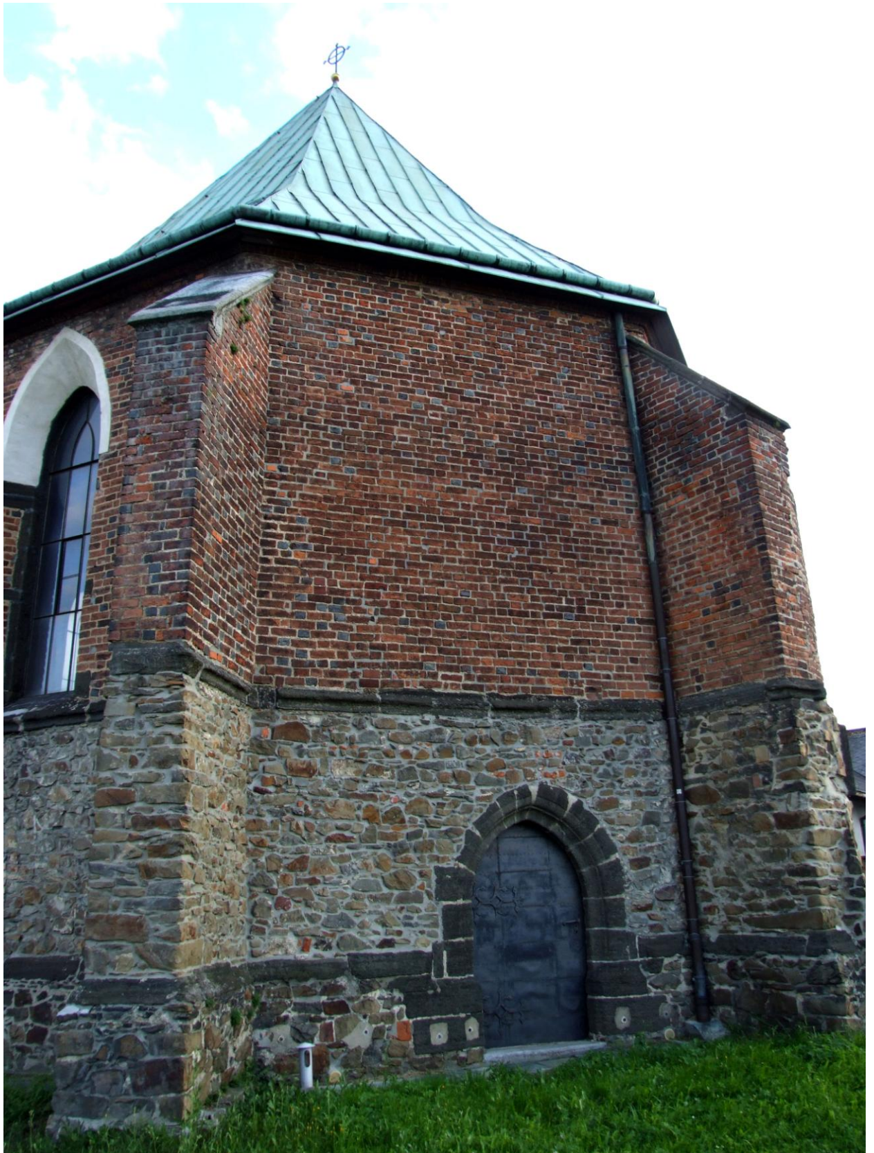
Obr. 187 Opava – Kateřinky, kaple sv. Kříže, pohled na severovýchodní průčelí.
