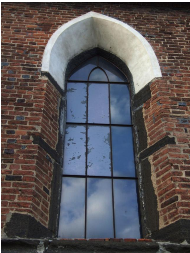
Obr. 182 Opava – Kateřinky, kaple sv. Kříže, okno jihozápadního průčelí.
