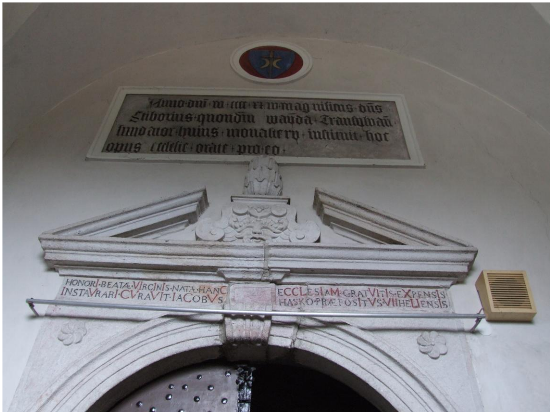
Obr. 144 Kostel Panny Marie v Novém Městě nad Váhem, detail západního portálu do lodi.
