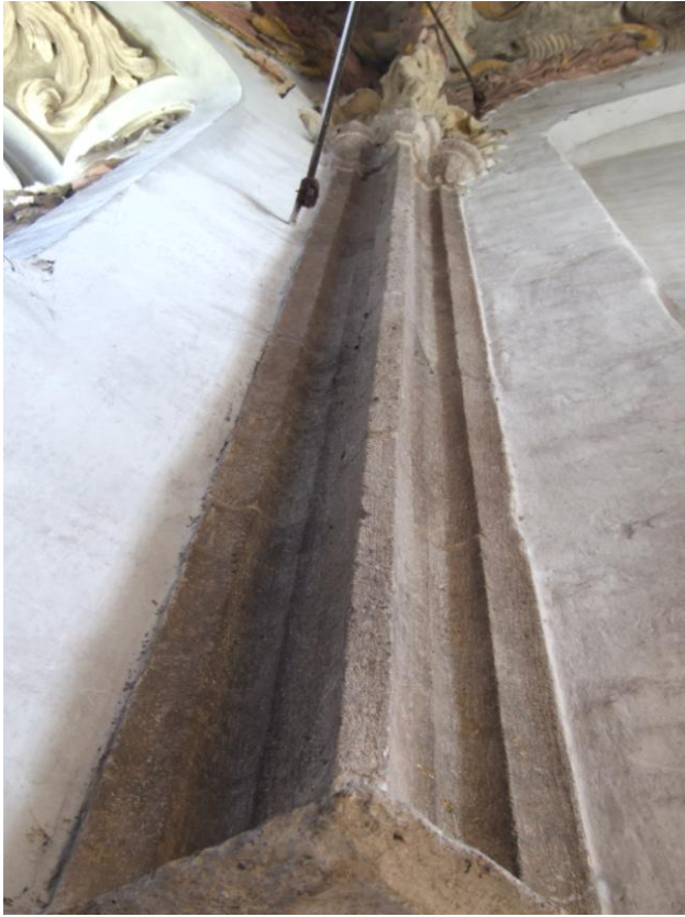
Obr. 151 Kostel Panny Marie v Novém Městě nad Váhem, elevace svazkové přípory presbytáře.
