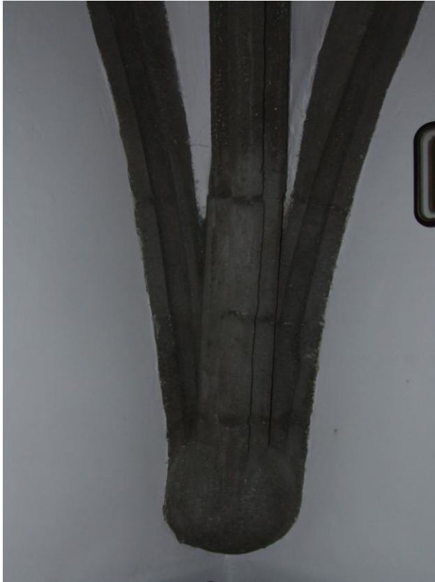
Obr. 156 Kostel Panny Marie v Novém Městě nad Váhem, kulová konzola klenby sakristie.
