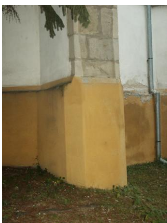
Obr. 133 Kostel Panny Marie v Novém Městě nad Váhem, detail soklu opěrných pilířů presbytáře.
