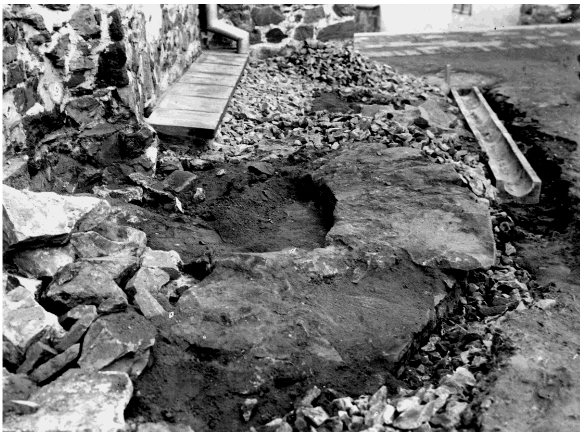
Obr. 213 Opava – Kateřinky, foto základů válcové schodišťové věže objektu kaple, odkryto r. 1949, foto Flasar, uloženo in: Fotoarchiv Slezského zemského muzea v Opavě, inv. č. A 8839.
