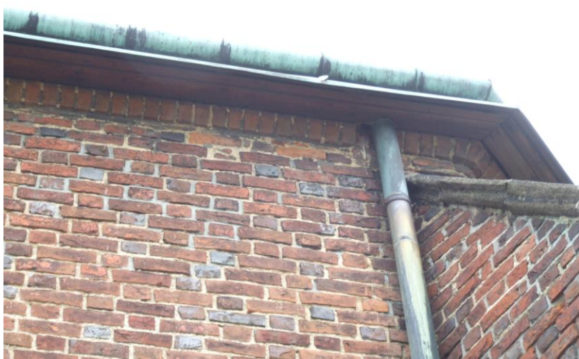
Obr. 200 Opava – Kateřinky, kaple sv. Kříže, detail korunní římsy.
