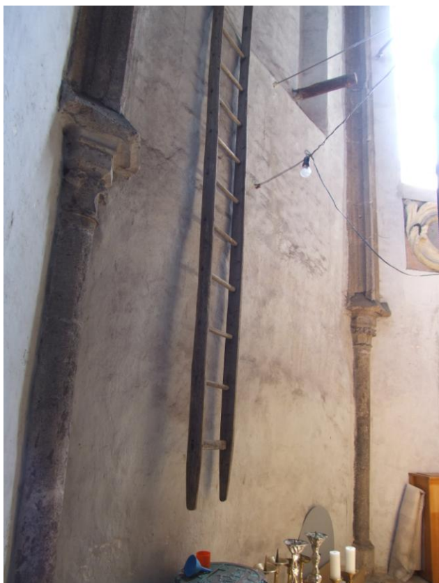
Obr.146 Kostel PM v Novém Městě nad Váhem, válcové přípory presbytáře za hl. oltářem.
