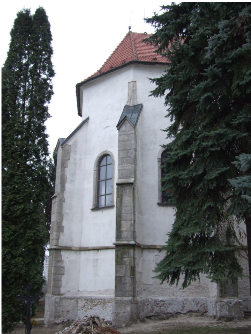
Obr. 132 Kostel Panny Marie v Novém Městě nad Váhem, pohled na presbytář od jihovýchodu.
