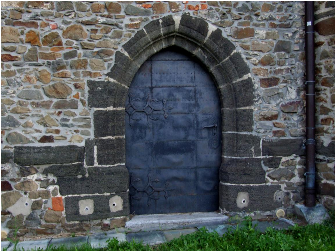
Obr. 188 Opava – Kateřinky, kaple sv. Kříže, pohled na portál na severovýchodní straně oktogonu.
