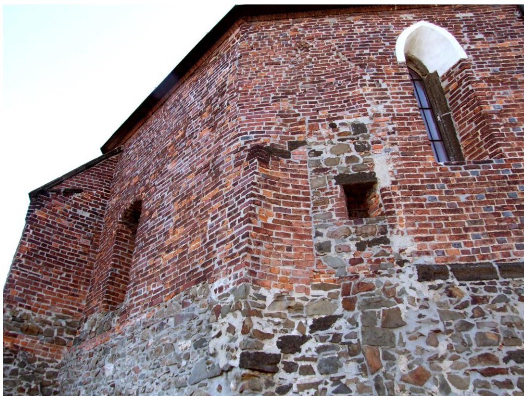
Obr. 194 Opava – Kateřinky, kaple sv. Kříže, situace při severozápadním nároží – sakristie. Schodišťová věžička, projevující se negativním vtiskem do hmoty kaple. Fragменты stupňů a portálu ze sakristie do věže.
