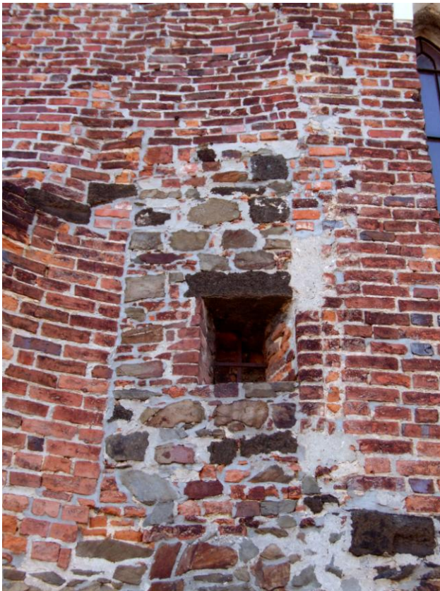
Obr. 198 Opava – Kateřinky, kaple sv. Kříže, detail zazděného portálu do 1. patra věže z kaple.
