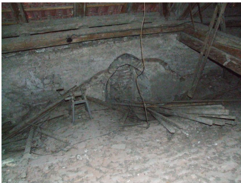
Obr. 161 Kostel Panny Marie v Novém Městě nad Váhem, původní lomené okno v bazilikální jižní zdi hlavní lodi.
