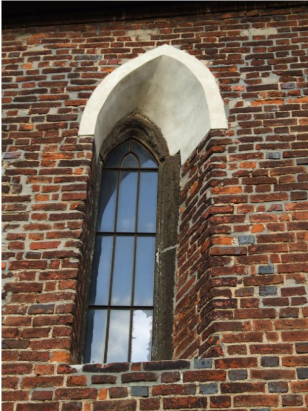
Obr. 197 Opava – Kateřinky, kaple sv. Kříže, detail okna severozápadního průčelí.
