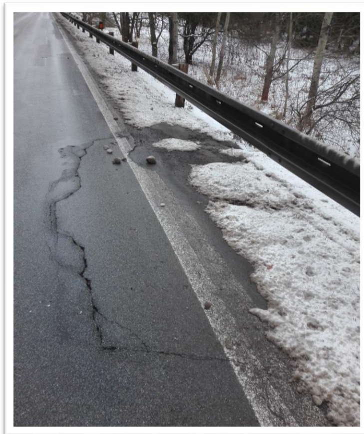
PORUCHA VOZOVKY V MÍSTĚ NÁSYPU
