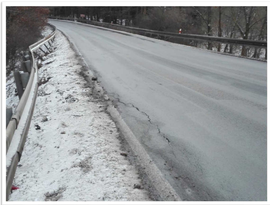
VYVRÁCENÁ SVODIDLA NAD PŘESYPANÝM MOSTEM
