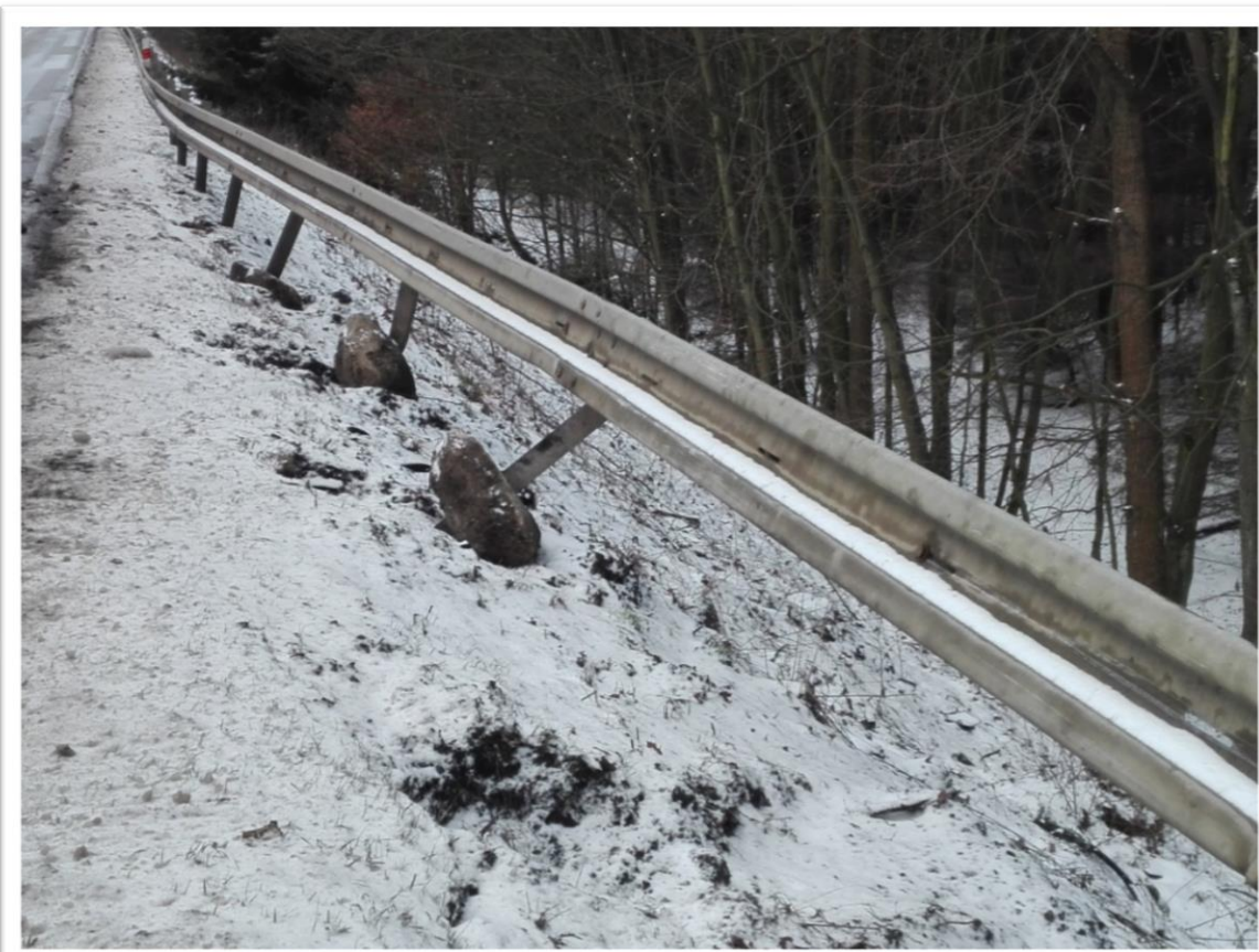
VYVRÁCENÁ SVODIDLA NAD PŘESYPANÝM MOSTEM
