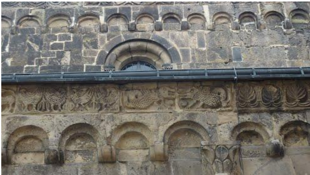
24. Quedlinburg, Sasko Anhaltsko, kostel sv. Servatia, třetí čtvrtina 12. století, obloučkový vlys na jižní fasádě hlavní i vedlejší lodi.
