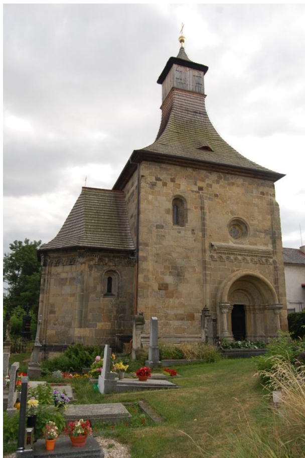
75. Vinec, kostel sv. Mikuláše, první polovina 13.století, pohled od jihu.
