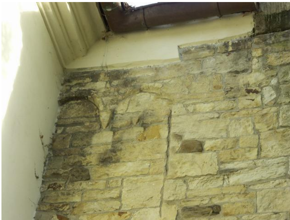
1. Zbraslav, kostel sv. Havla, první polovina 12. století, fragment obloučkového vlysu na východní části severní fasády.
