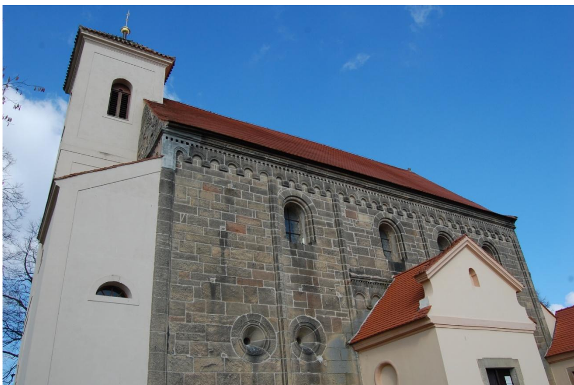
66. Potvorov, kostel sv. Mikuláše, první polovina 13. století, pohled od jihu.
