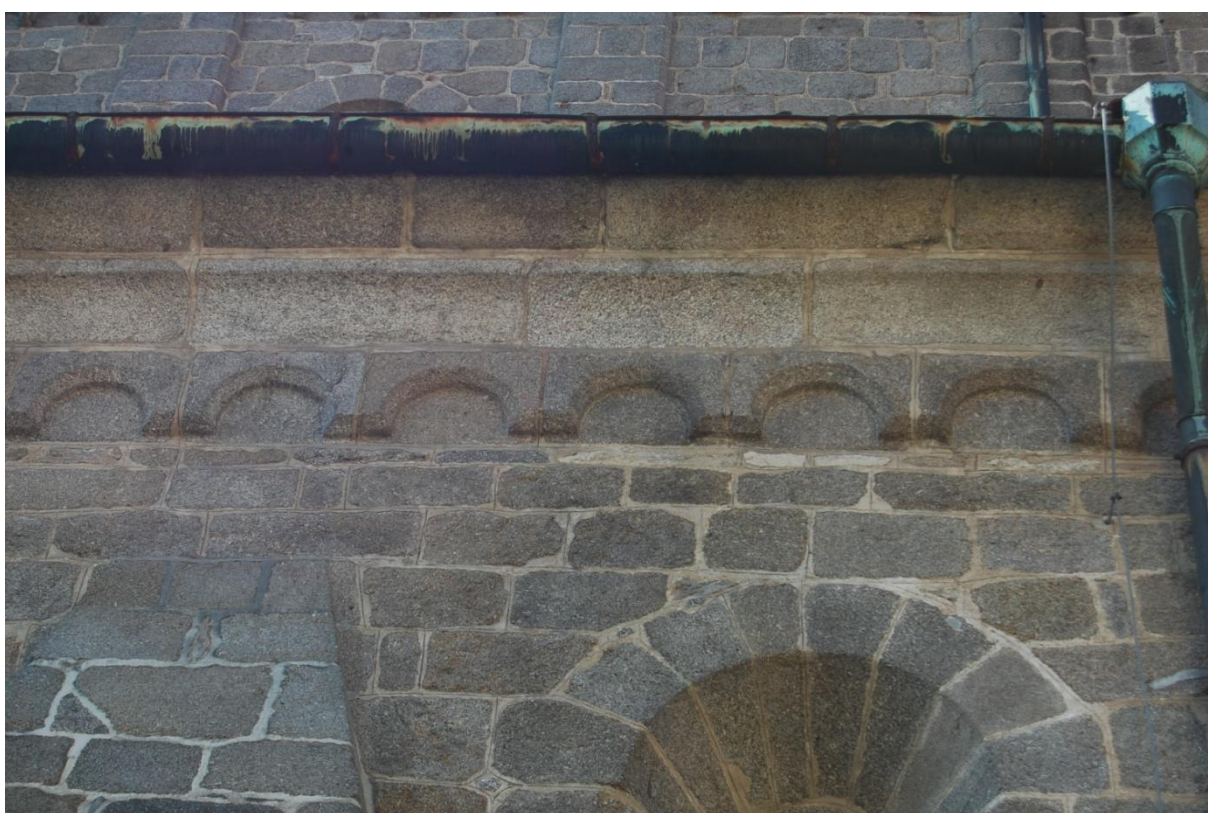
106. Třebíč, kostel sv. Prokopa, první polovina 13. století, obloučkový vlys na severní boční lodi.
