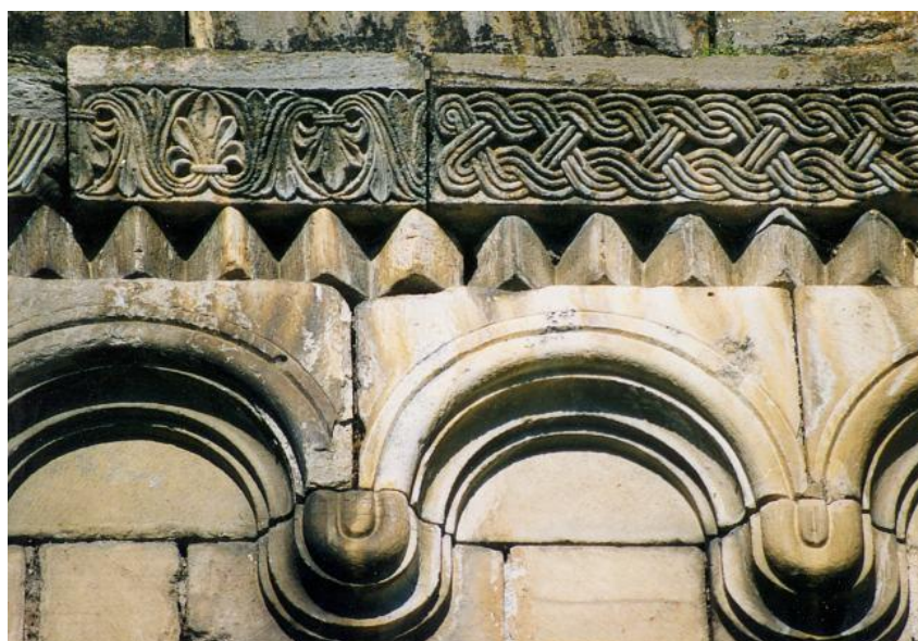
18. Gurk, Korutany, dóm Nanebevzetí Panny Marie, druhá polovina 12. století, detail obloučkového vlysu na jižní fasádě boční lodi.
