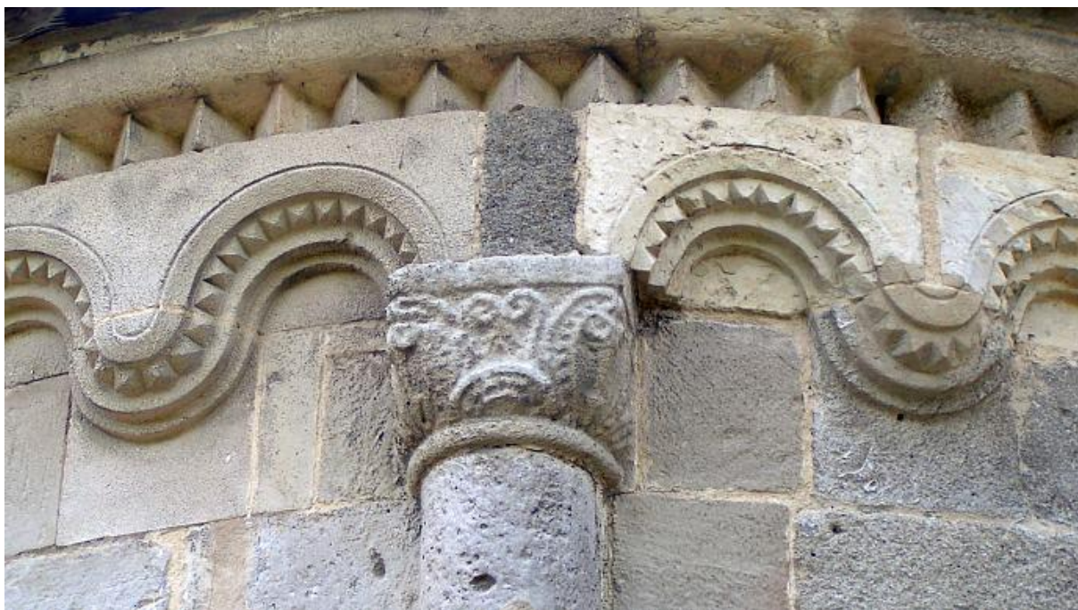
31. Bad Deutsch-Altenberg, Dolní Rakousko, kostnice sv. Leonarda, první polovina 13. století, detail obloučkového vlysu.
