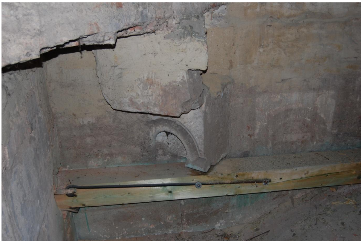
117. Velehrad, klášterní komplex s bazilikou Nanebevzetí Panny Marie, první polovina 13. století, fragment obloučkového vlysu v jihozápadní části transeptu.
