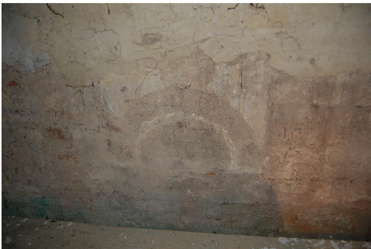
118. Velehrad, klášterní komplex s bazilikou Nanebevzetí Panny Marie, první polovina 13. století, stopy po obloučkovém vlysu v jižní části transeptu.
