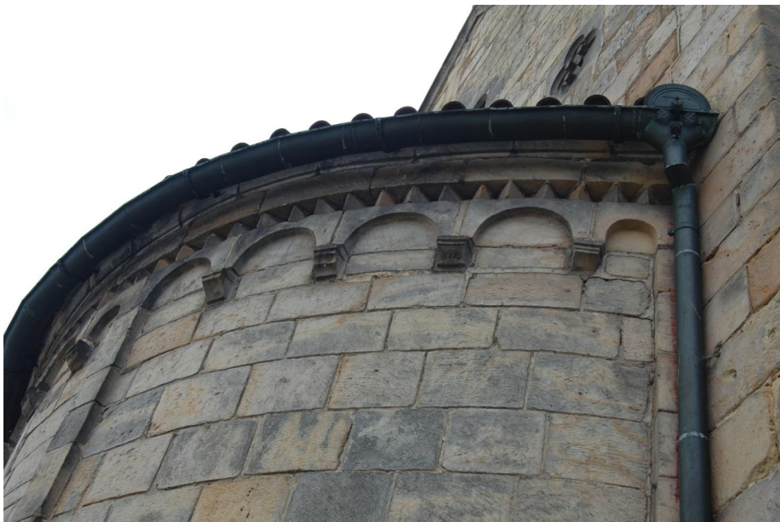
47. Mohelnice nad Jizerou, kostel Panny Marie, třetí čtvrtina 12. století nebo první třetina 13. století, severní lizénové pole apsidy.
