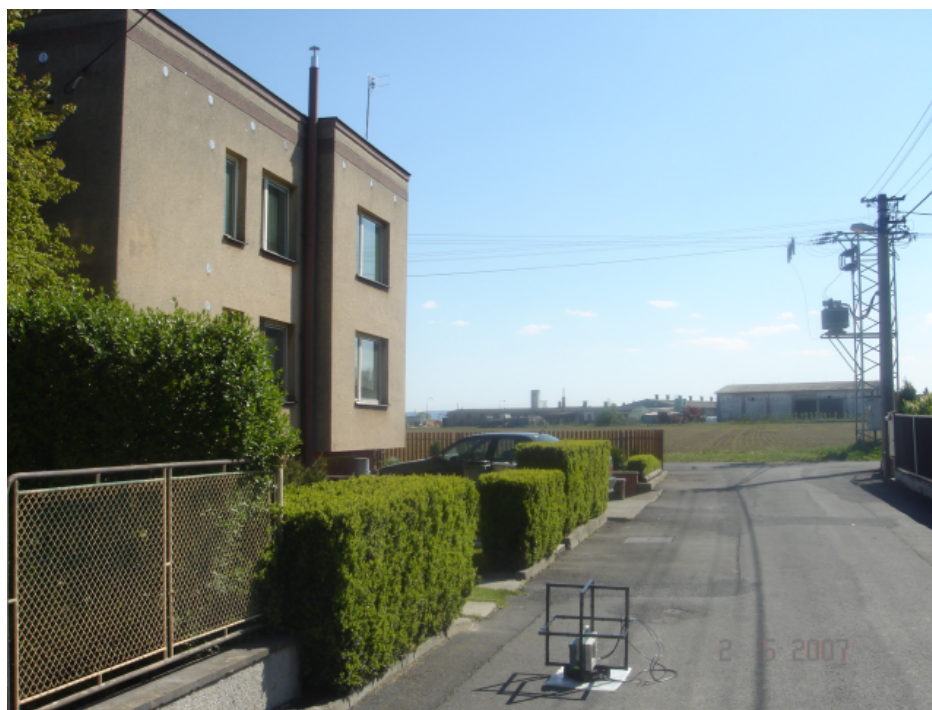
Obr. 7 Příklad rodinného domu v ČR s blízkým transformátorem, rozvody elektrického vedení. Měřicí aparatura na snímku není v měřicí poloze. (Fotografie V. Jiřík)
