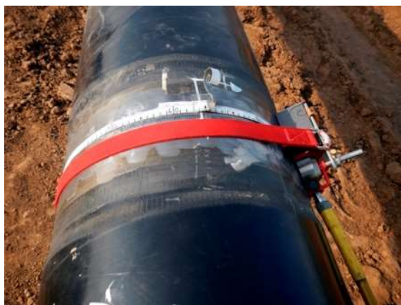
Obr. 4.4 Zkouška prozářením (RT) [41]
