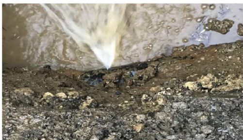
Obr. 3.2 a) díra v potrubí b) porucha spoje
