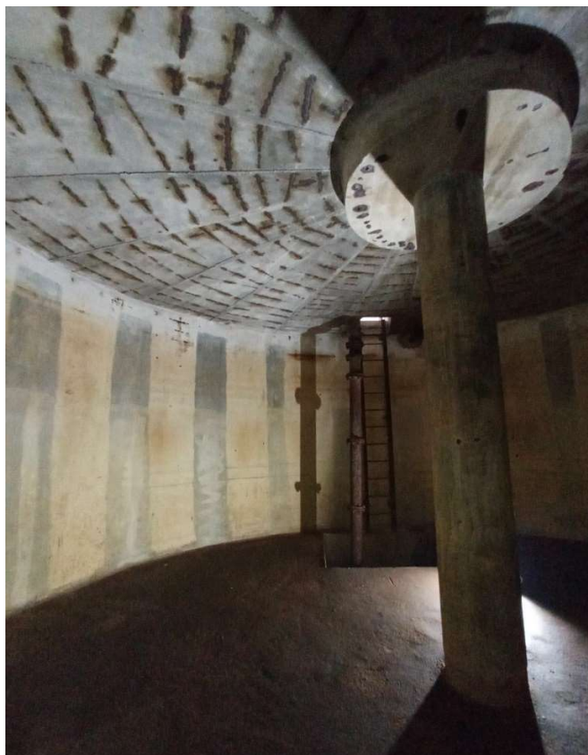
Obr. 6.12 Akumulační nádrž vodojemu
