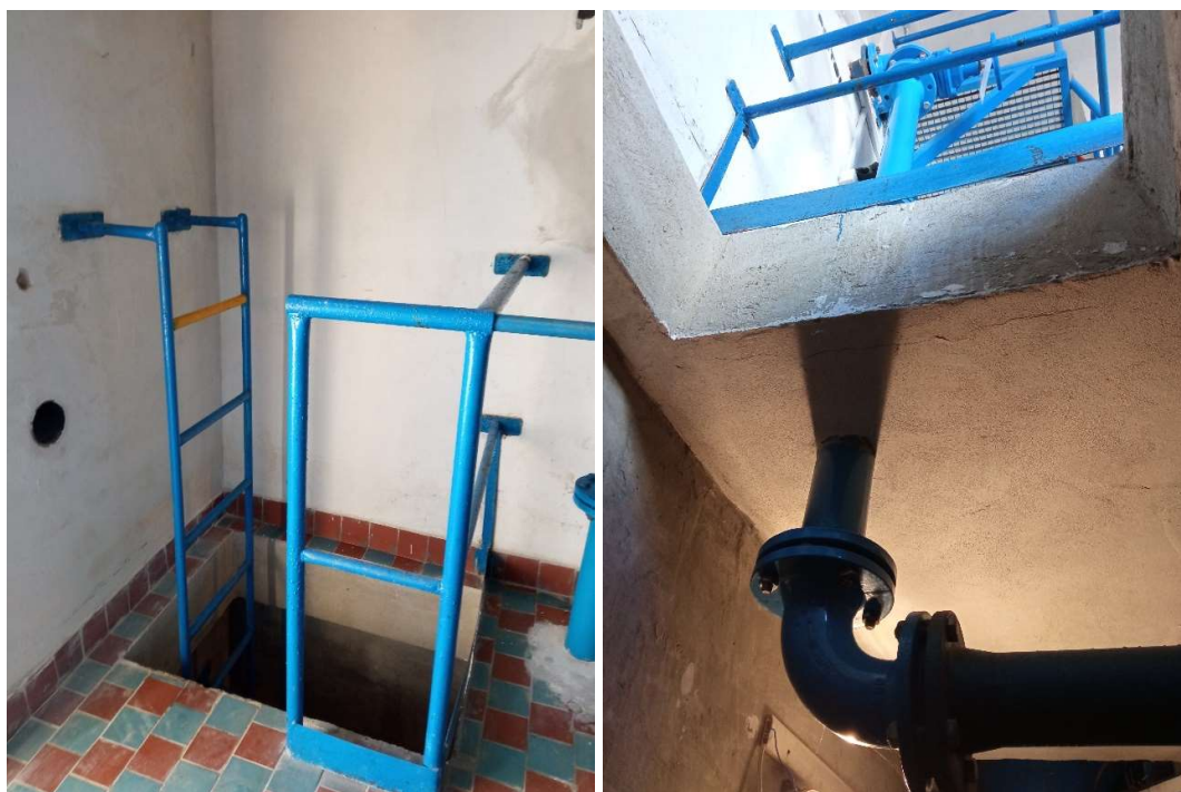
Obr. 6.15 Vstup do armaturní komory
