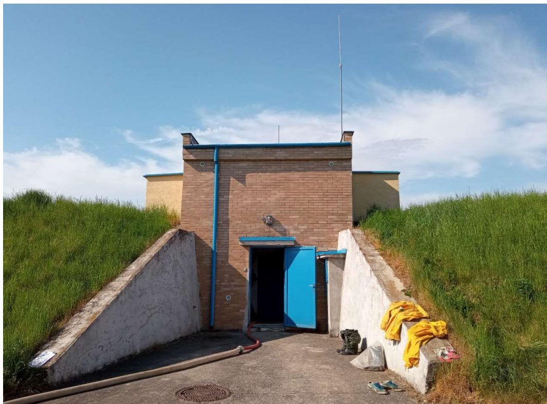
Obr. 6.10 Čelní pohled na vodojem
