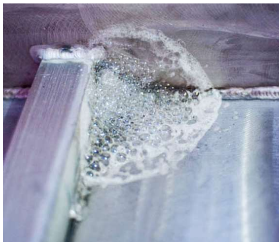
Obr. 4.7 Zkouška těsnosti (LT) [46]
