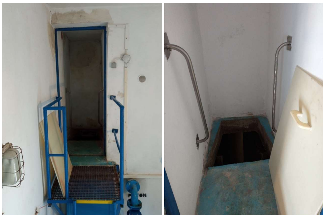
Obr. 6.11 Vstup do akumulční nádrže
