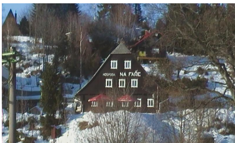
Příloha 8: Bývalá fara z roku 1782, Čenkovice (autor: Lenka KOHLOVÁ, 2. 3. 2012)
