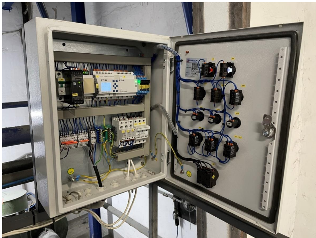
Príloha A. 2: Rozmiestnenie komponentov v rozvádzači
