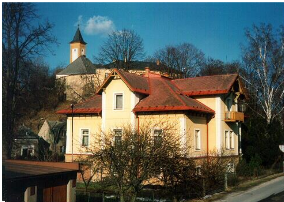
Příloha 1 – Modlitebna v Zábřehu exteriér 1 (Sbor ČCE Zábřeh, 2017)
