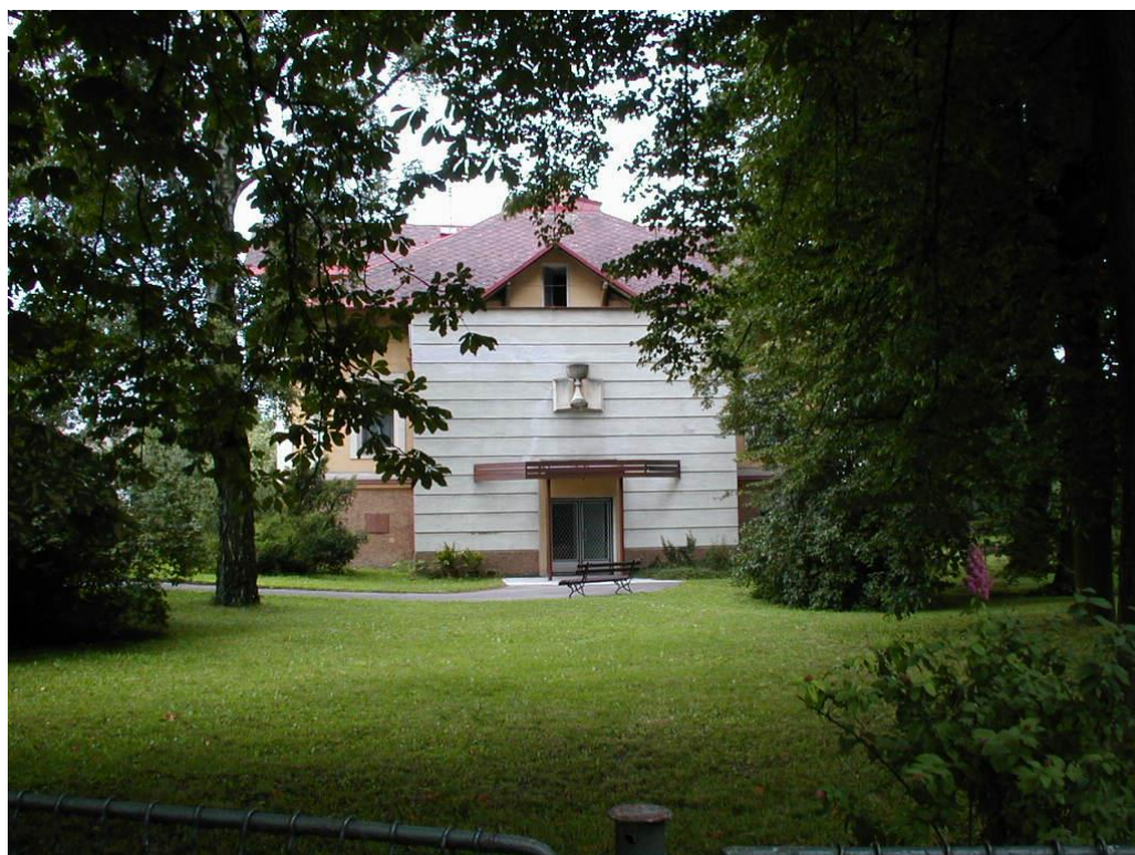
Příloha 2 – Modlitebna v Zábřehu exteriér 2 (Sbor ČCE Zábřeh, 2017)
