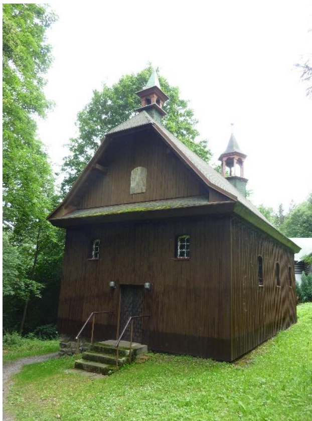
Obr. 9 Poutní kaple Panny Marie – pohled od příjezdové cesty z Deštného v Orlických horách (Mastíková, červenec 2017)
