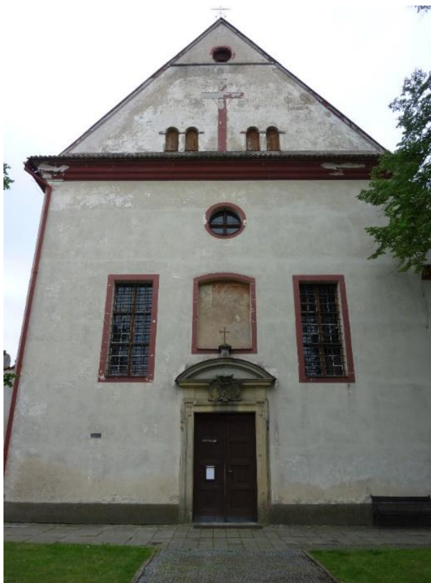
Obr. 21 Kostel Narození Páně – pohled z Kupkova náměstí (Mastíková, červenec 2017)
