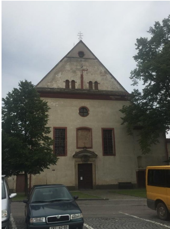
Obr. 40 Kostel Narození Páně vstupní průčelí – pohled z Kupkova náměstí (Mastíková, červenec 2017)
