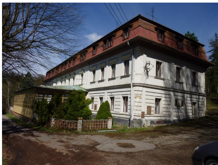
Obr. 39 Opuštěný lázeňský dům – pohled od kaple svaté Barbory (Mastíková, duben 2018)
