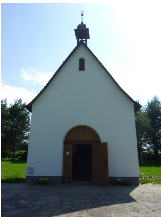
Obr. 52 Schönstattská kaplička zblízka – pohled od kostela (Mastíková, červenec 2017)
