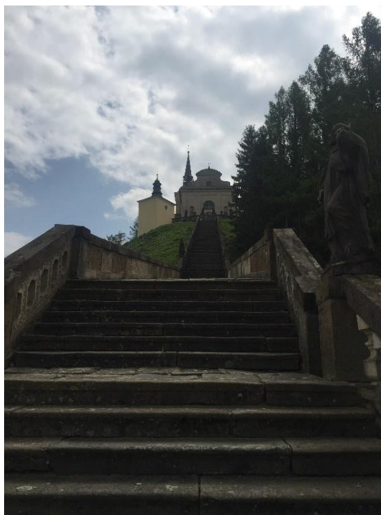
Obr. 20 Detail na schodiště (Mastíková, květen 2017)
