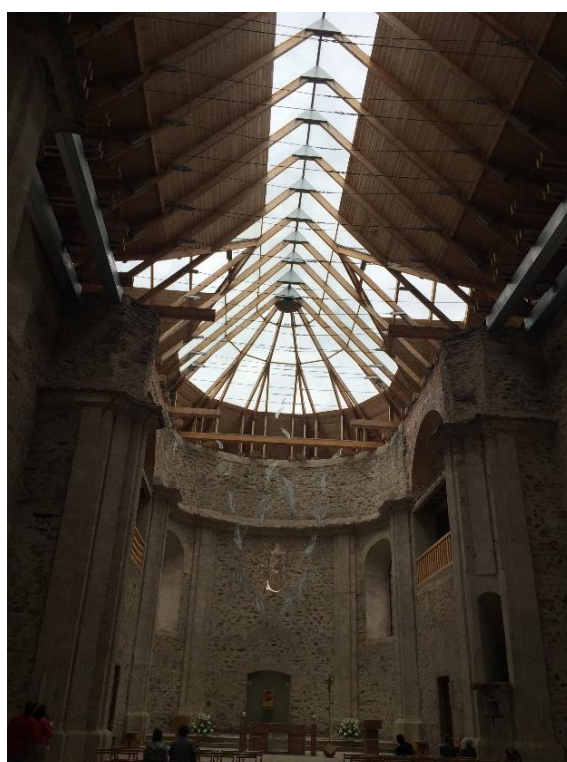
Obr. 32 Prosklená střecha ve tvaru kříže – pohled od vstupu (Mastíková, červenec 2017)
