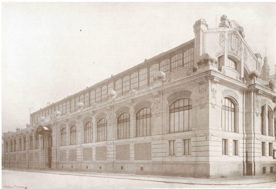
Obrázek 42 Alois Čenský, Objekt městské tržnice na Smíchově, 1909.
