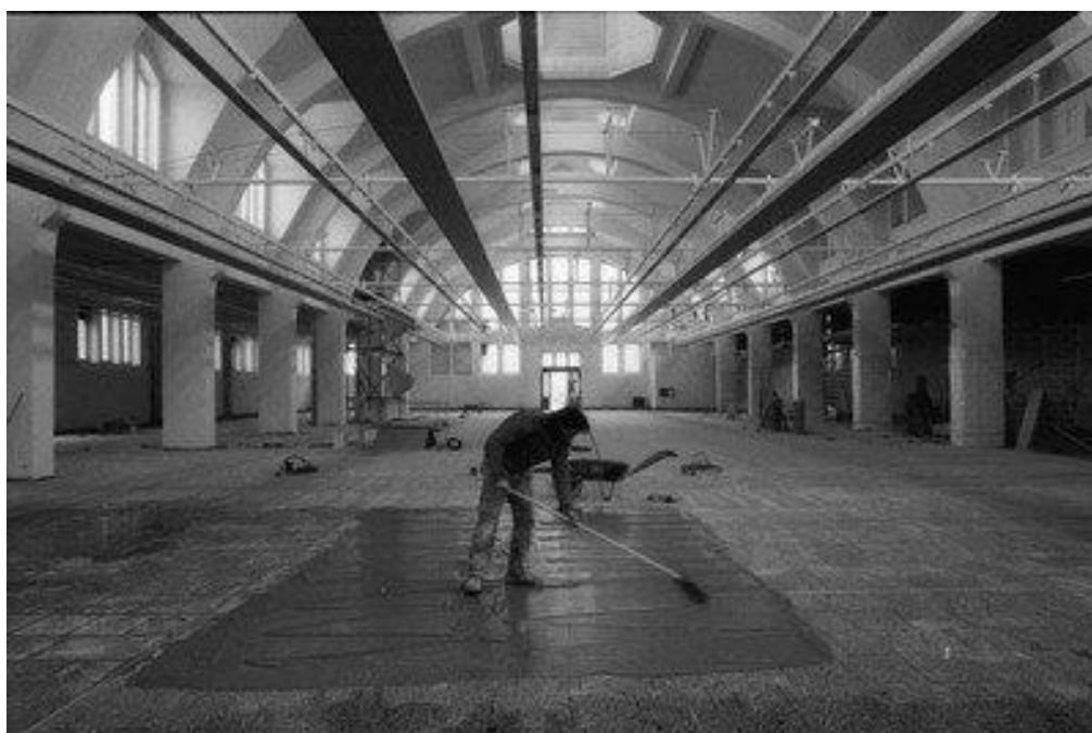
Obrázek 59 Franz Drobny, Interiér tržnice během rekonstrukce, 1994.
