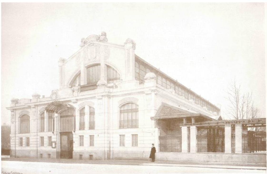
Obrázek 43 Alois Čenský, Objekt městské tržnice na Smíchově, 1909.
