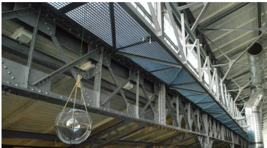
Obrázek 37 Antonín Turek, Ocelová konstrukce ústřední tržnice na Vinohradech po rekonstrukci, 2017.
