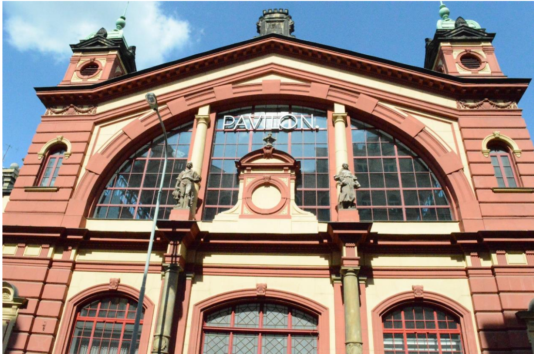
Obrázek 35 Antonín Turek, Průčelí ústřední tržnice na Vinohradech po rekonstrukci, 2017.
