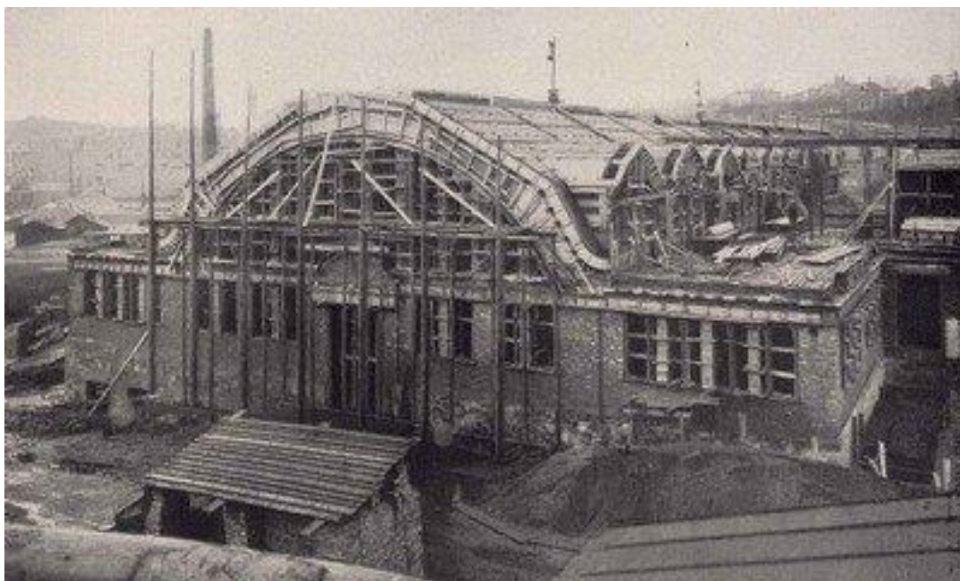
Obrázek 54 Franz Drobny, Výstavba městské tržnice v Karlových Varech, 1913.
