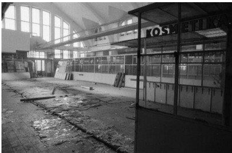
Obrázek 58 Franz Drobny, interiér městské tržnice v Karlových Varech před rekonstrukcí, 1993
