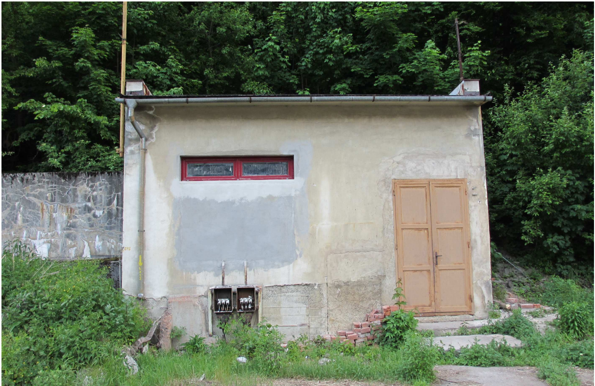
Obr. 2 Stávající stav budovy MVE, vlevo je vidět betonová stěna náhonu [6]
