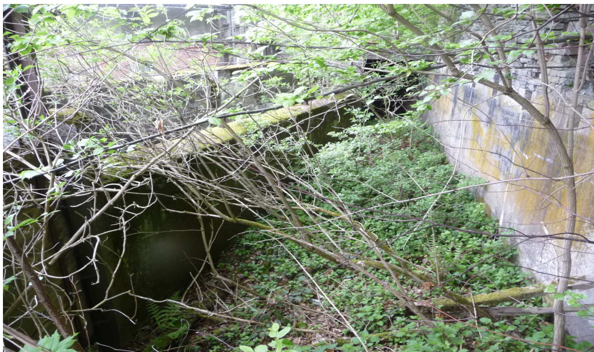
Foto 6 Pohled na nátokový objekt SO3_1 stav v roce 2013 [6]
