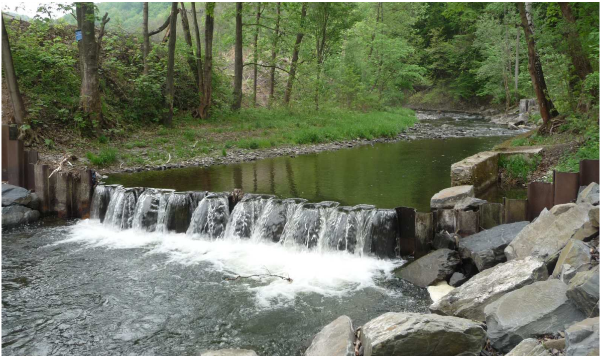
Obr. 1 Stávající stav jezu ze štětovnic [6]
