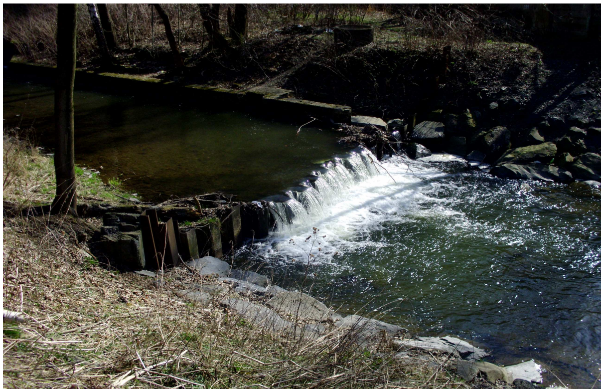
Foto 1 Pohled na štětovou stěnu z pravého břehu [7]
