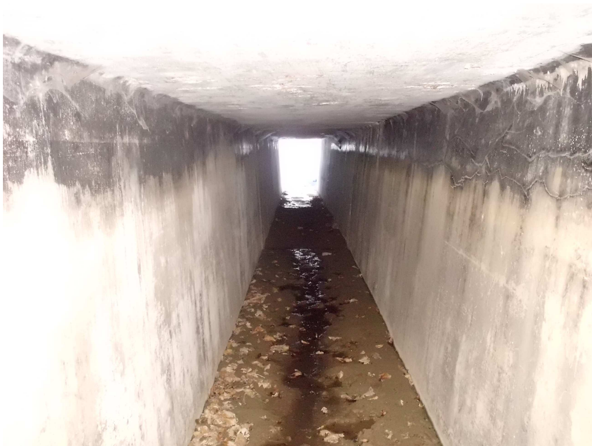
Foto 5 Zastřešený betonový náhon pohled k budově MVE [7]
