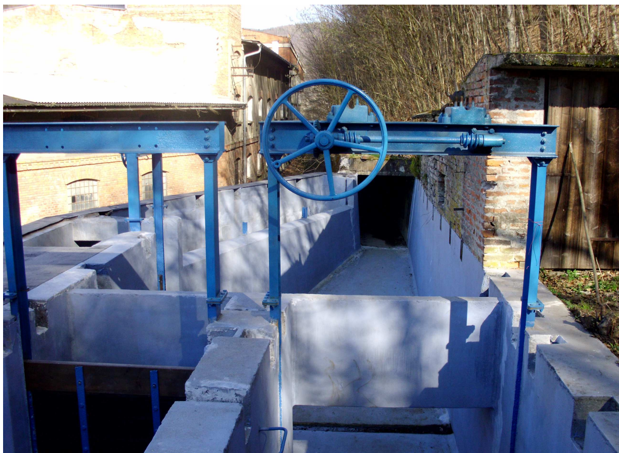
Foto 7 Pohled na nátokový objekt SO3_1 stav v roce 2014 [7]
