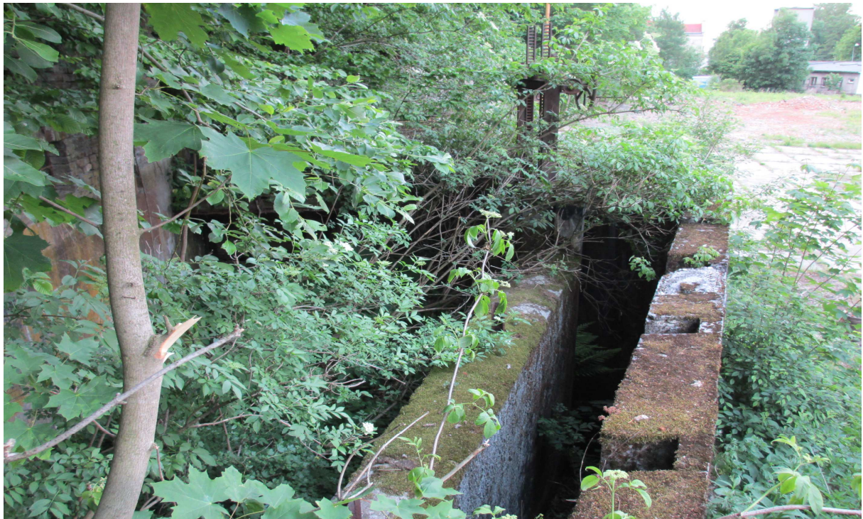
Obr. 3 Pohled od betonového přivaděče před odstraněním nánosů a vegetace, dobře je vidět přelivná hrana jalového přepadu [6]
