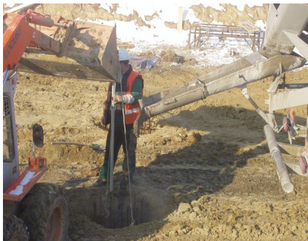
Obrázek 17: Betonáž zavěšeného armokoše
