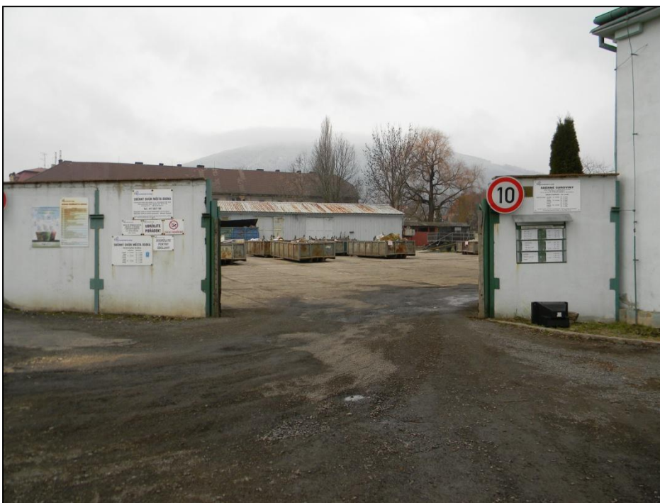
Foto č. 5 – Vstupní brána do sběrného dvora v ulici Dolnonádražní v lokalitě města Osek
