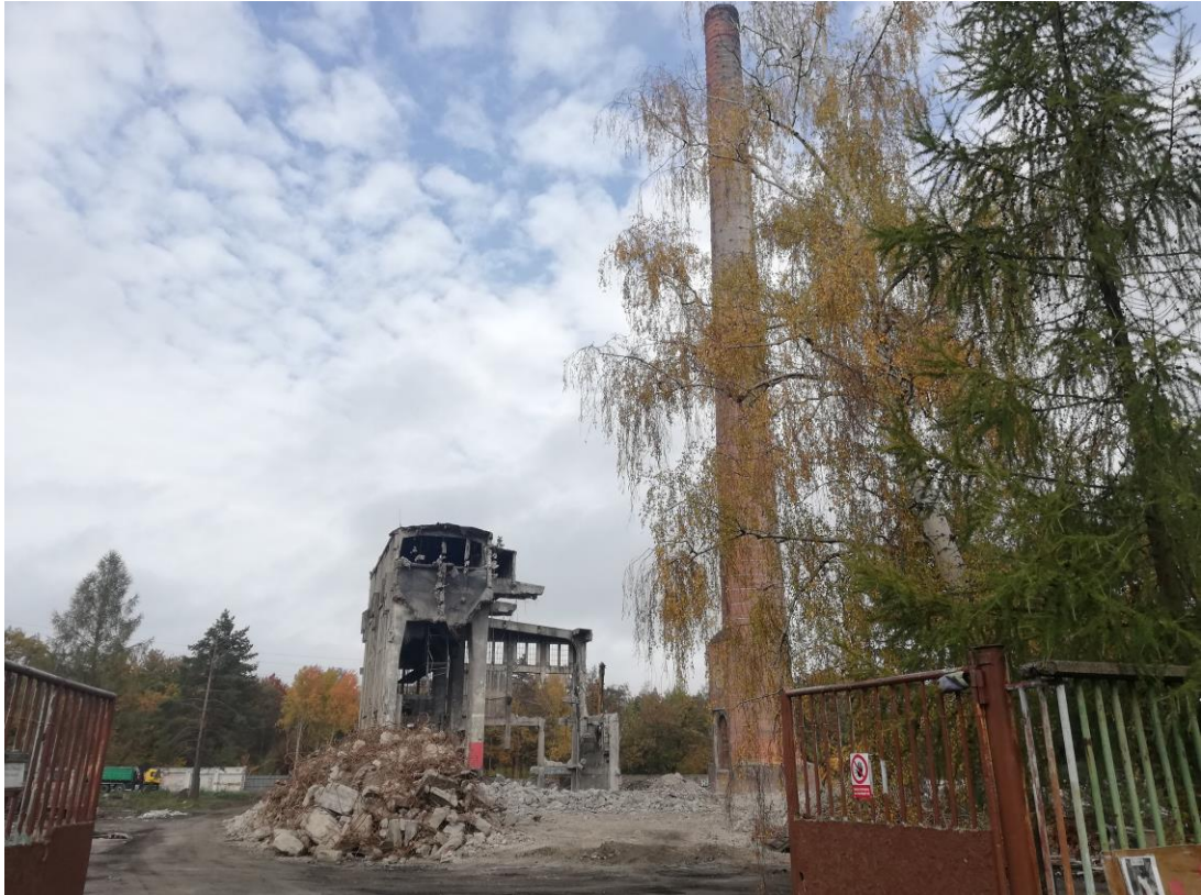
Obrázek 22: probíhající demolice elektrárny dolu Schoeller říjen 2022
