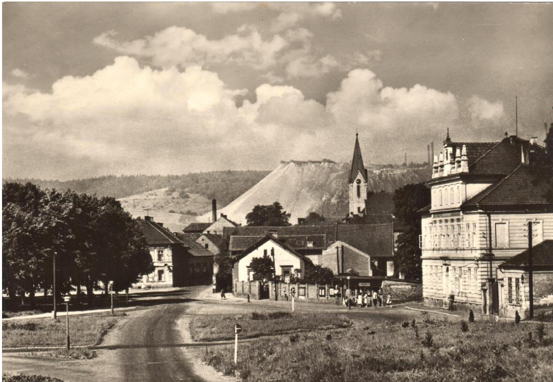
Obrázek 33: pohled na haldu u sv. Jiří z centra Libušína – 60. léta 20. st. zdroj: archiv autora
