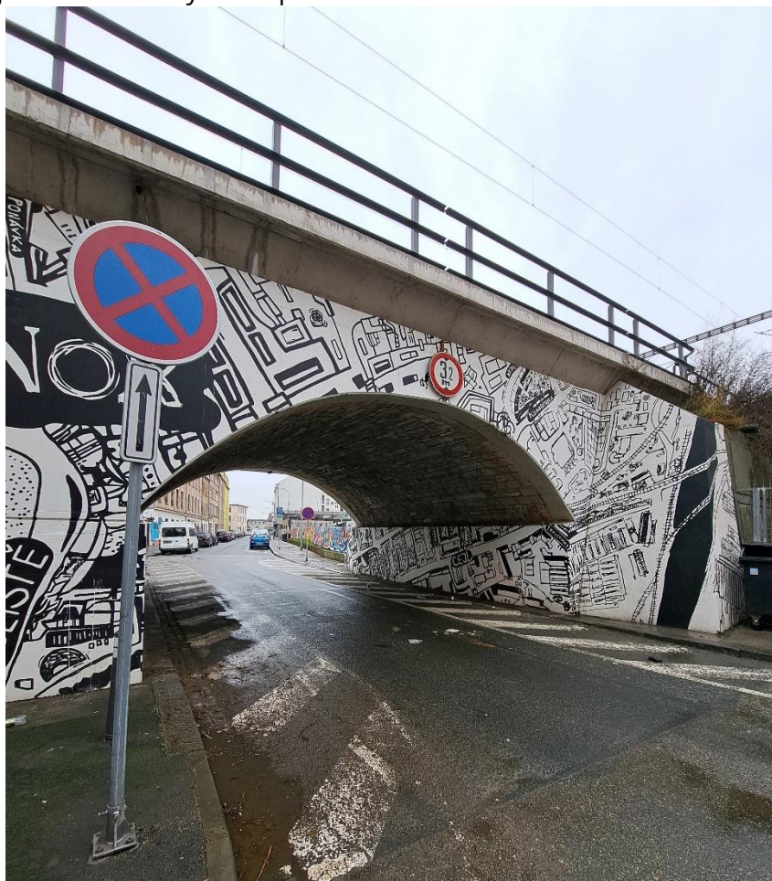
Obrázok 10 Podjazd pod viaduktom na ulici Vlhekaj, pohľad zo severu
