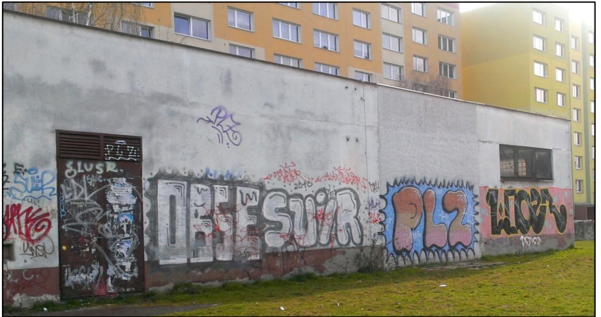
Obr. č. 7: Kotelna na sídlišti Nové Sady
