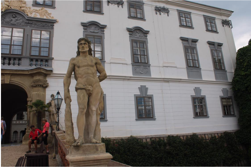
Obr. 5: Průčelí vstupu s barokními sochami, zámek Lysice
