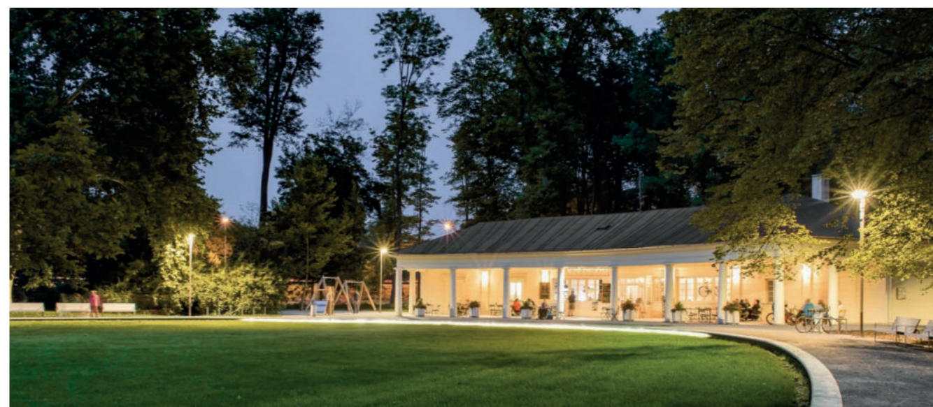
osvětlená obnovená Klatovská kolonáda
