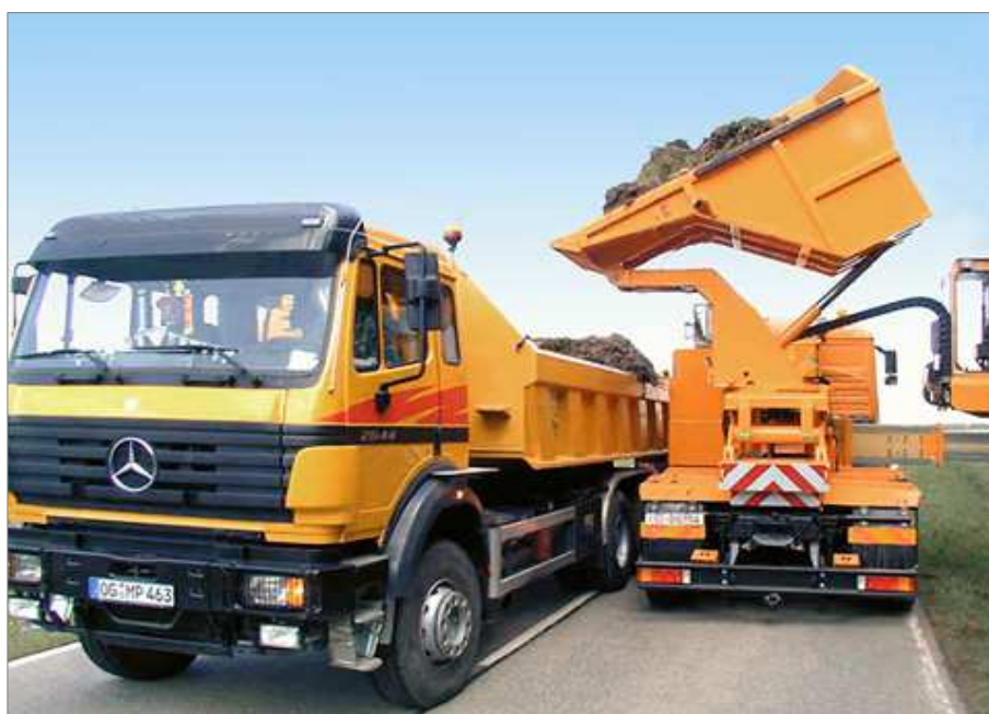
Obr. 9: Vysypávání vytěžené zeminy frézou Mulag HS 2400 [15]
