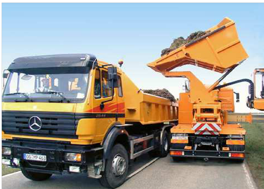
Obr. 9: Vysypávání vytěžené zeminy frézou Mulag HS 2400 [15]
