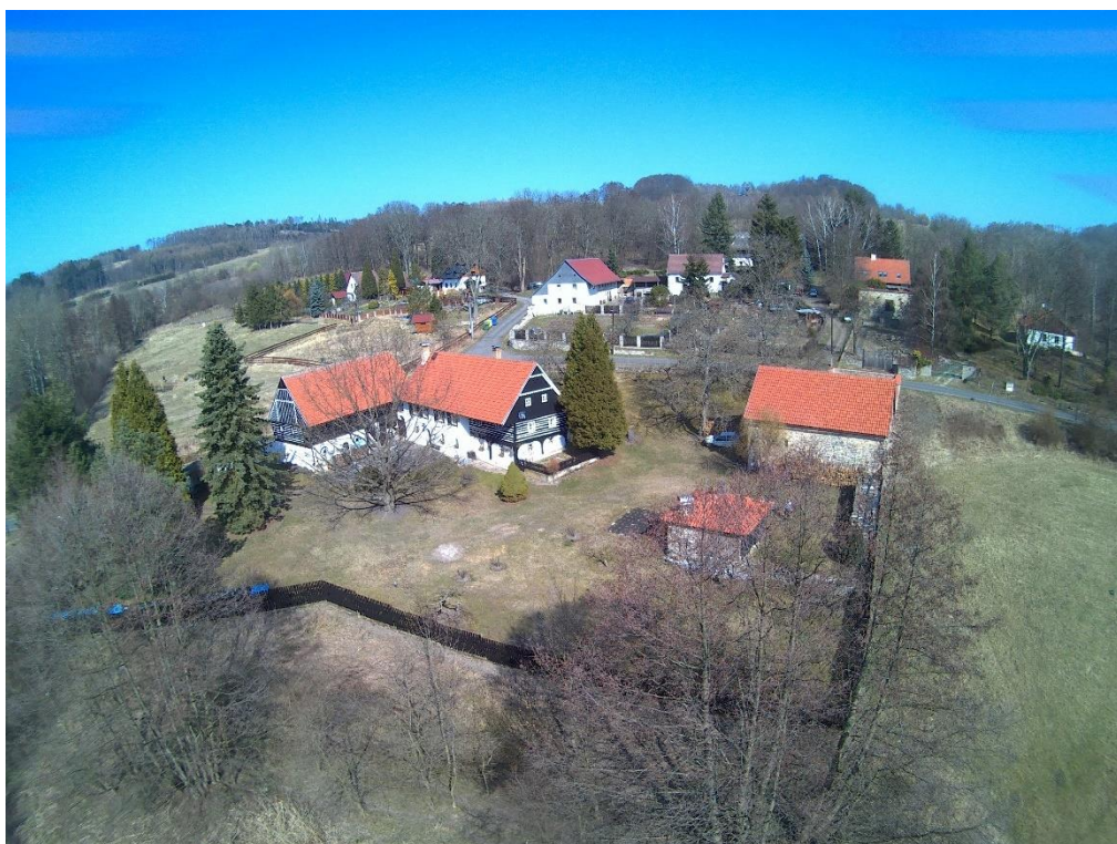
Příloha 8: Fotodokumentace – Zemědělská usedlost č. p. 44, pohled od jihovýchodu, 24. 3. 2022
