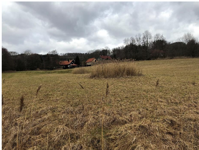
Obrázek 31: Zamokření pozemků, blíže je zarostlá šachtice krytého kanálu a v pozadí je zarostlá šachtice odvodnění pozemku se zamokřením, 5. 2. 2022 (vlastní foto)
