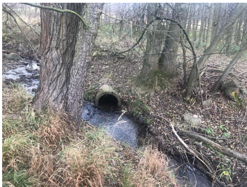
Obrázek 36: Drenážní výust' – krytý kanál, foceno proti směru toku Trojhorského potoka, 27. 11. 2021 (vlastní foto)
