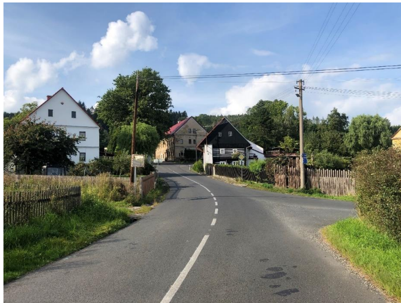
Obrázek 15: Centrum obce Rýdeč, pohled od jihu, 13. 9. 2021 (vlastní foto)
