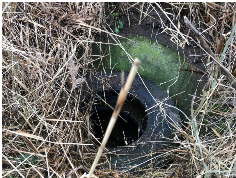
Obrázek 35: Pohled do kontrolní šachtice krytého kanálu, 5. 2. 2022 (vlastní foto)
