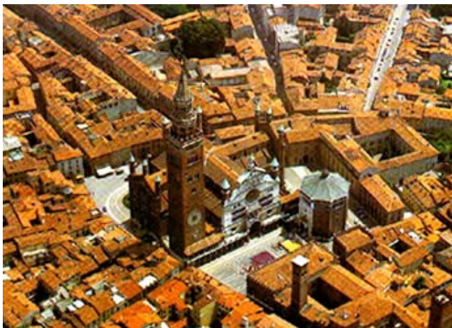
35/ demolice okolního prostoru katedrály Santa Maria Assunta, Cremona, 1932
