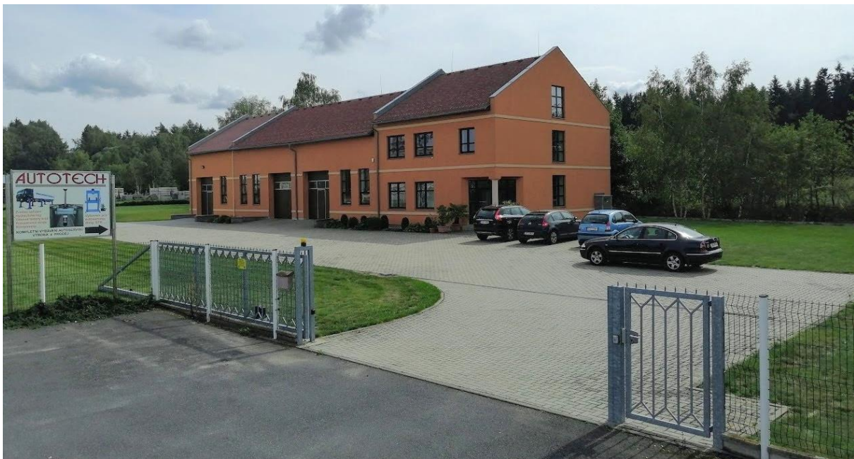
Obr. 1 Firemní areál AUTOTECH - VT, s.r.o.
