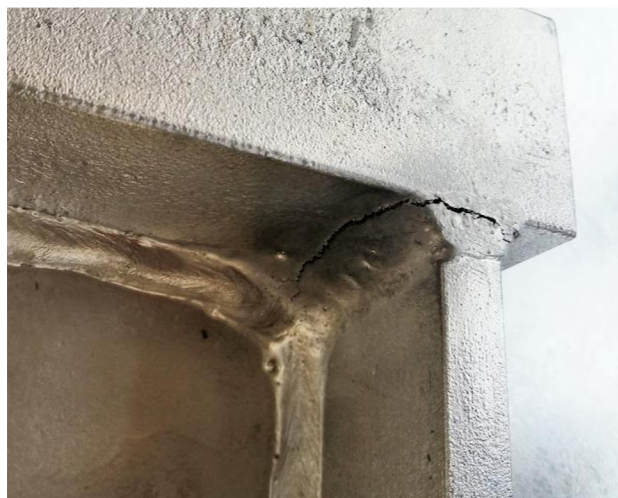
Obr. 17 Prasklý svar po rovnání.
